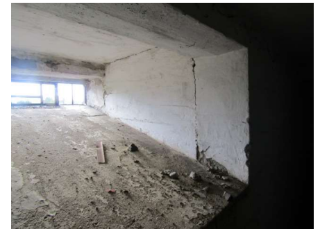
Description: vybavenie 1NP
