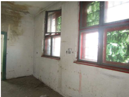
Description: vybavenie 1NP
