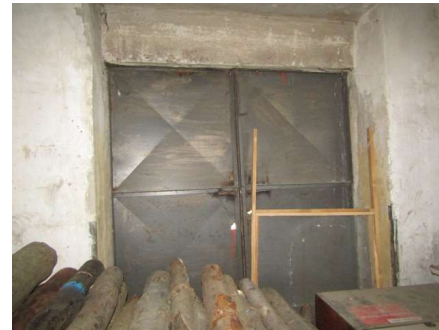
Description: vybavenie 1NP
