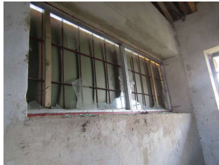
Description: vybavenie 1NP
