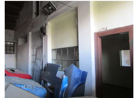
Description: vybavenie 1NP
