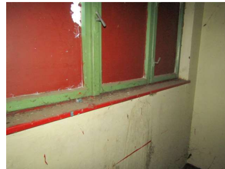
Description: vybavenie 1NP
