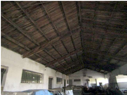
Description: vybavenie 1NP
