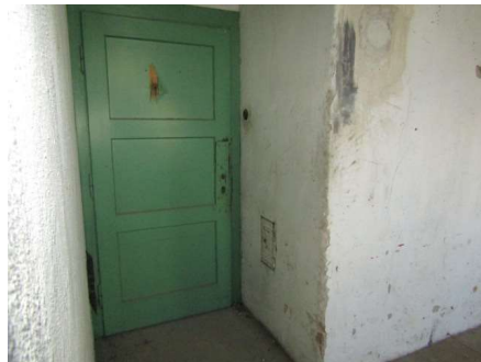
Description: vybavenie 1NP
