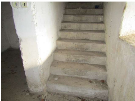
Description: vybavenie 1NP
