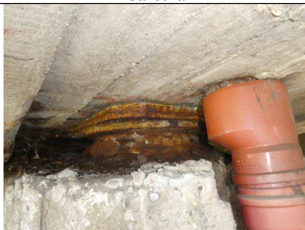
Obr. 12 – Poškodené ložisko – rameno Šancová, opora č. 10
