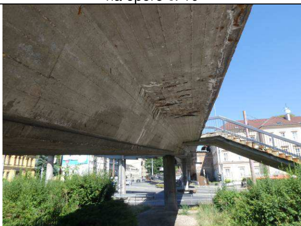
Obr. 15 – Inkrustácie na ramene Šancová
