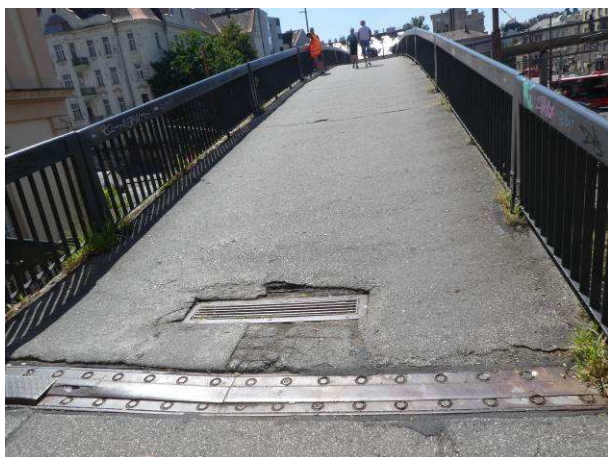
Obr. 13 – Poškodený odvodňovač a mostný záver na opore č. 10
