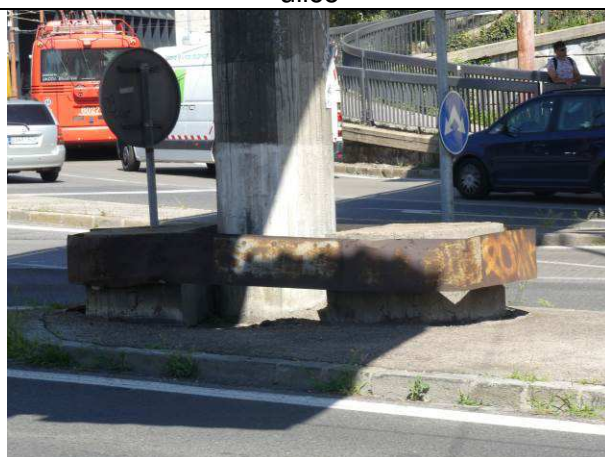
Obr. 18 – Zábrana proti nárazu na podpere č. 8
