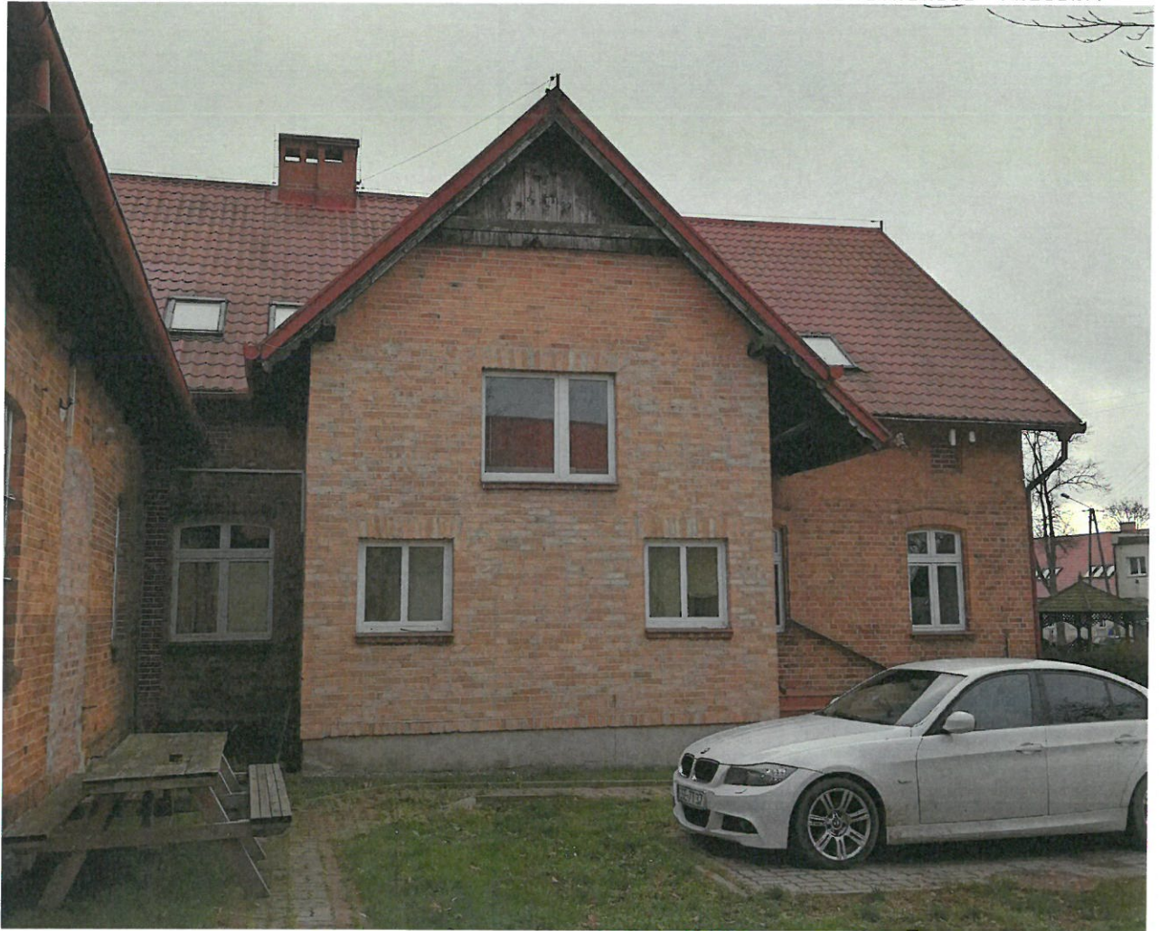
Fot. 6 – fragment elewacji północnej.
