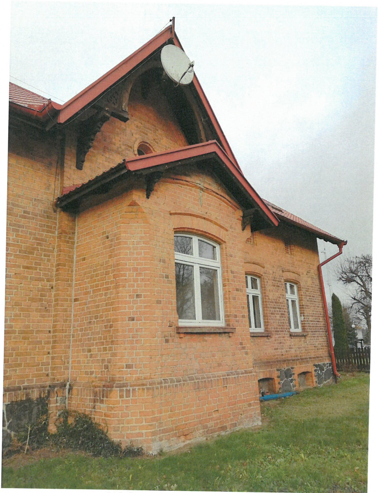
Fot. 2 – fragment elewacji frontowej (południowej).
