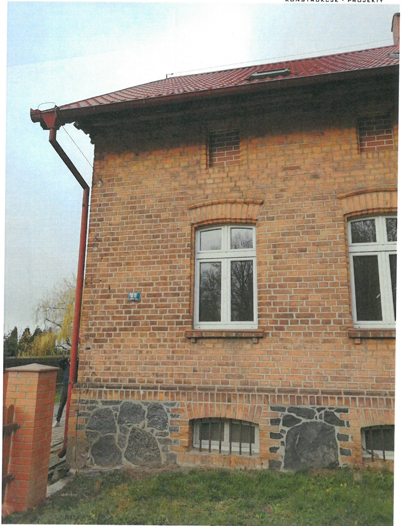
Fot. 3 – fragment elewacji frontowej (południowej).
