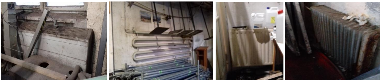
Obr. 18: Vykurovacie telesá – (zľava doprava) budova A; budova B; budova C; budovy D, E a F
