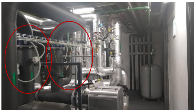
Obr. 6: Meranie spotreby tepla v OST
