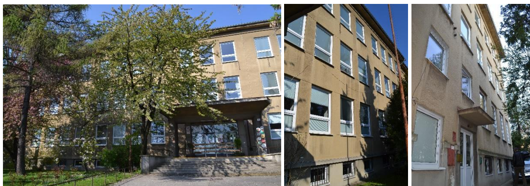
Obr. 7: Základná umelecká škola, Karloveská 3, Bratislava
