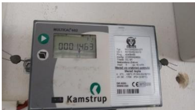
Obr. 6: Meranie spotreby tepla v OST
