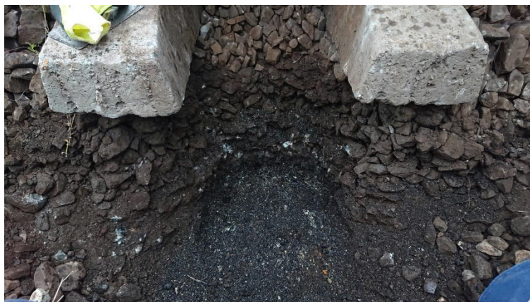
Obrázok 4 Pohľad na do kopanej sondy pre SZS-30 s charakteristickým zložením konštrukčných vrstiev, kde sa pod vrstvou koľajového kameniva nachádza vrstva škváry.
