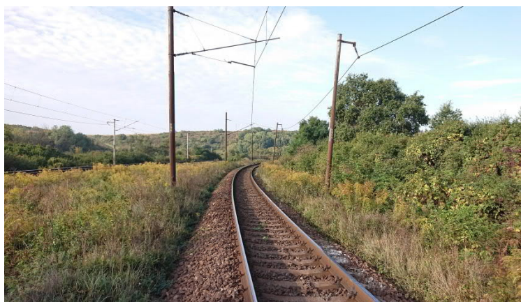
Obrázok 7 Pohľad na naklonené trakčné stožiare v úseku železničnej trate v žkm 83,200 – 83,400.
