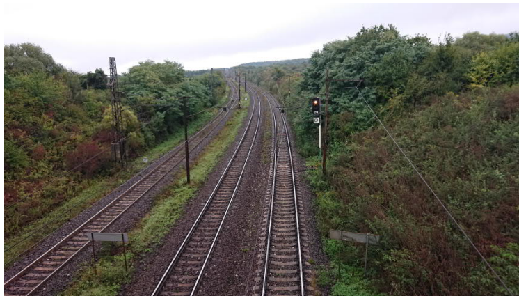
Obrázok 8 Pohľad na zárezový úsek železničnej trate v žkmcca78,600 – 78,900. Pozdĺžne odvodňovacie priekopy sú zarastené, nevyčistené.
