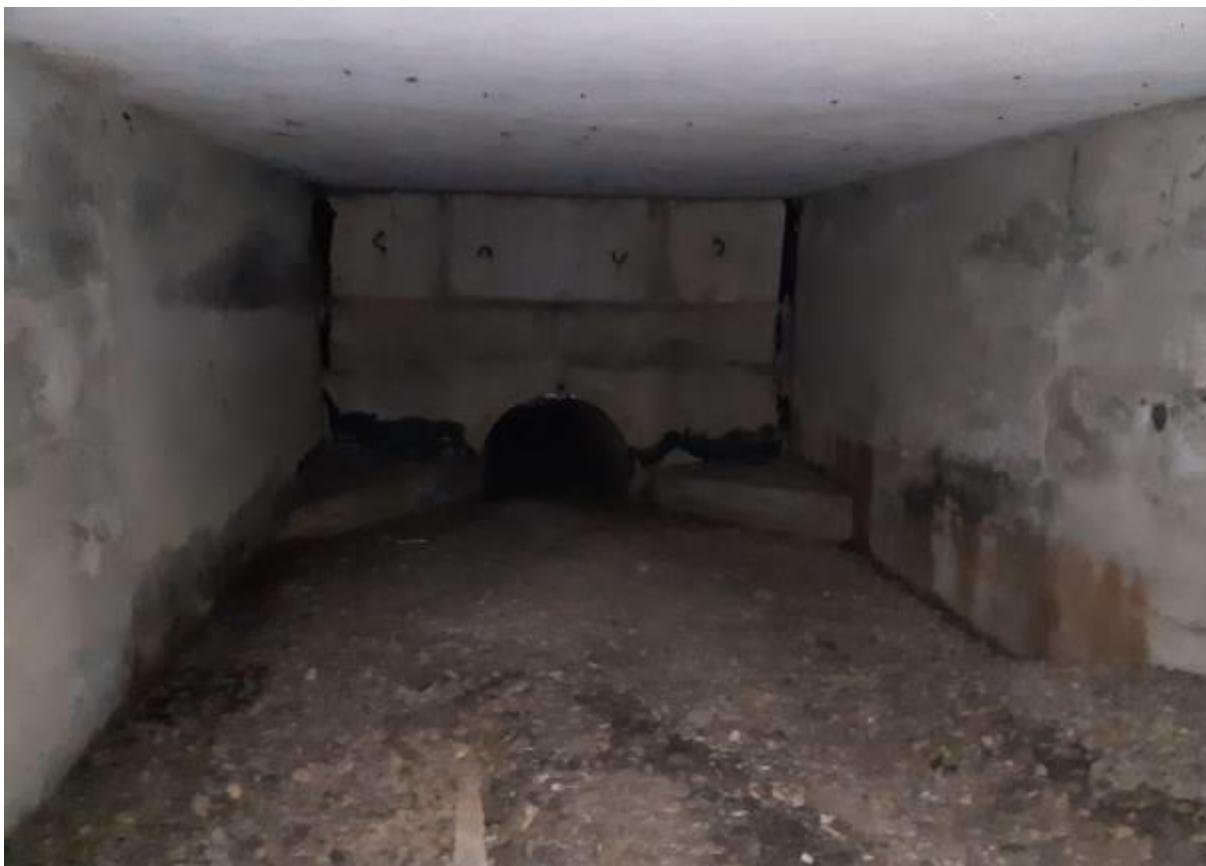
Obr. Pohľad na napojenie mosta pod koľajami č. 1,2 na rúrový priepust pod koľajou ŠRT
