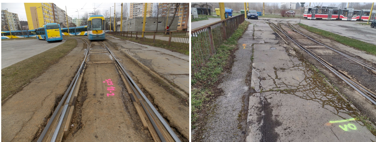
Obrázok 3 a 4 Porušený asfaltobetónový kryt v úsekoch výhybiek obratiska Važecká
