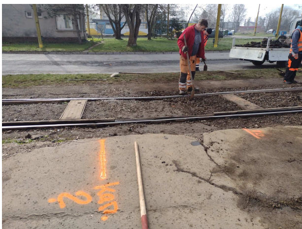
Obrázok 5 Náhrada AB krytu kamenivom v mieste výhybky
