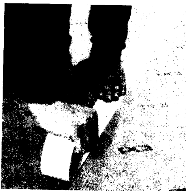
V suchých priestoroch prelepiť spoje krepovou lepiacou páskou, v priestoroch zaťažených vlhkosťou utesniť s PCI Pectape®...
