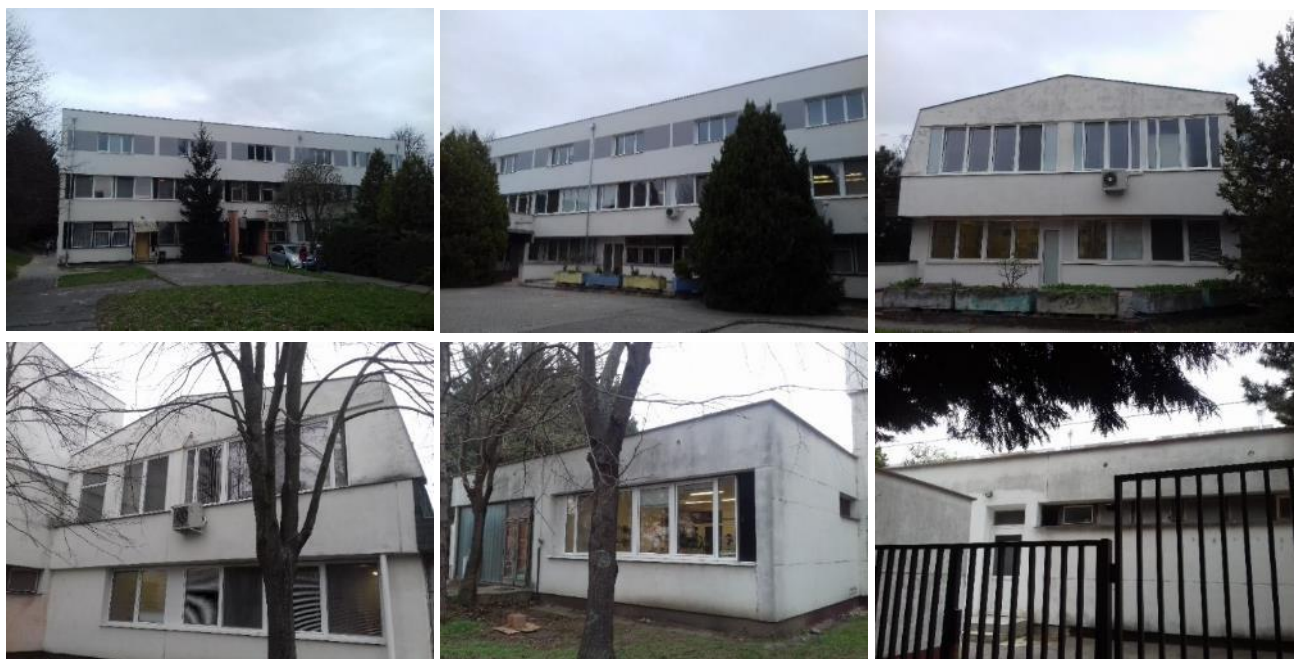
Obr. 5: Pohľady na budovu ZUŠ
