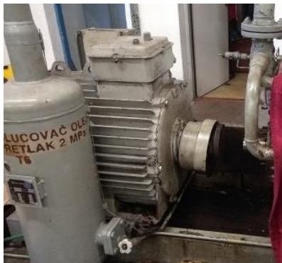
Obr. 21: Odlučovač oleja (tlaková nádoba)
