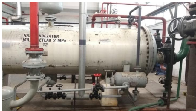
Obr. 19: Kondenzátor chladiva NH 3
