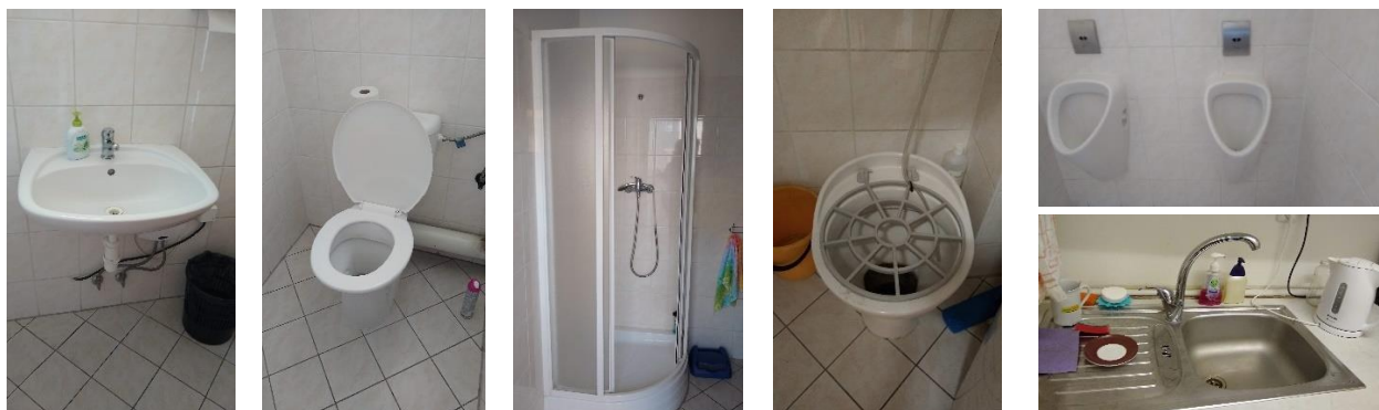
Obr. 14: Zariaďovacie predmety v budove
