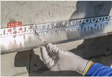
ILUSTRÁČNÁ FOTKA - Správne založenie zakladacej lišty
