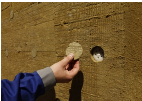
ILUSTRÁČNÁ FOTKA - Zátka pre zapustenú montáž rozperných kotiev
