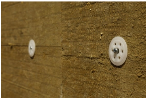
ILUSTRÁČNÁ FOTKA - Ukážka vloženia rozpernej kotvy do predvŕtaných otvorov
