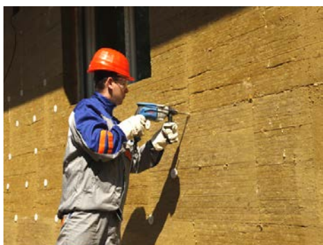
ILUSTRÁČNÁ FOTKA - Ukážka vrtania otvorov - kolmo na stenu
