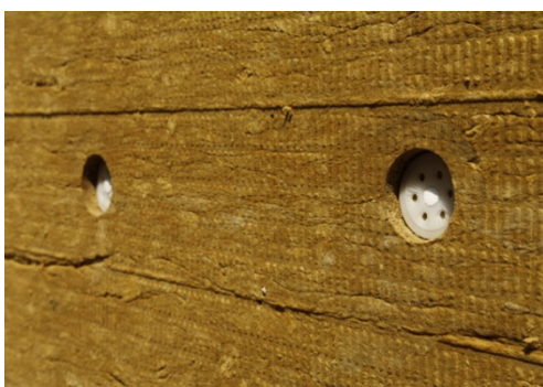
ILUSTRÁČNÁ FOTKA - Ukážka montáže zapustenia rozperných kotiev
