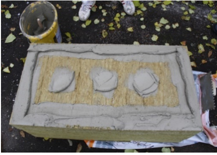
ILUSTRÁČNÁ FOTKA - Ukážka správneho nanosenia lepidla na fasádnu dosku
