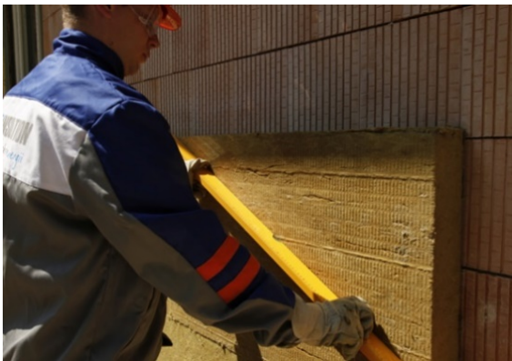
ILUSTRÁČNÁ FOTKA - Nivelácia dosky pri lepení na stenu
