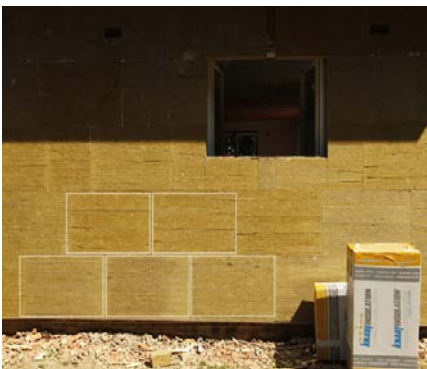
ILUSTRÁČNÁ FOTKA - Ukážka správneho uloženia dosiek na stene
