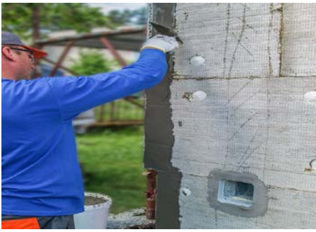
ILUSTRÁČNÁ FOTKA - Osadenie rohovej lišty
