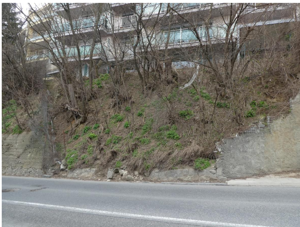
Obr. 14: Úsek medzi dvoma časťami múru, ktorý bol rozobraný v rámci výstavby.
