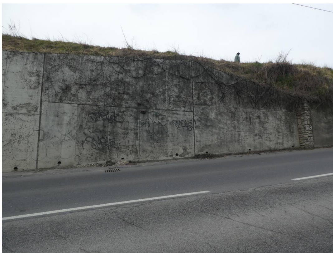
Obr. 24: Betónový gravitačný múr.
