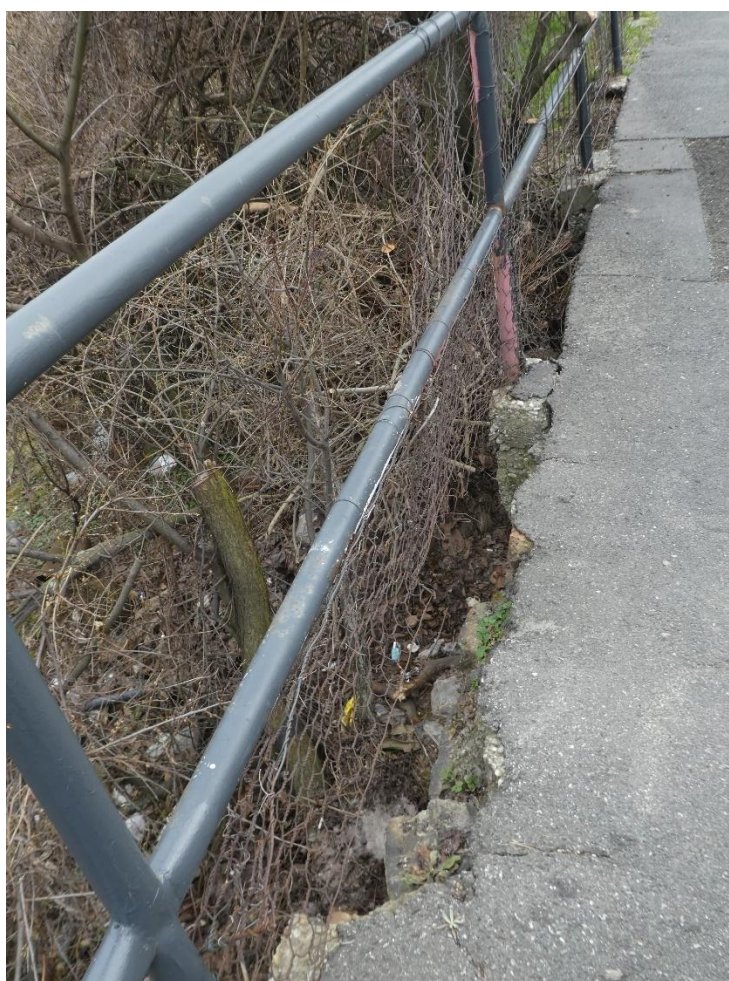
Obr. 30: Napojenie zábradlia na korunu múru.
