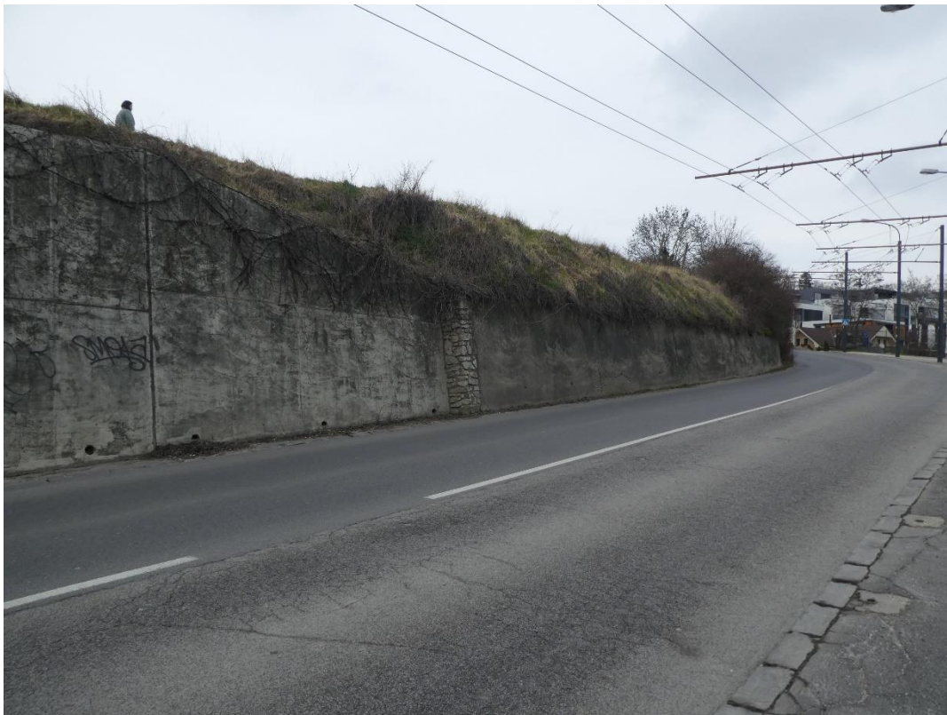
Obr. 25: Betónový gravitačný múr.
