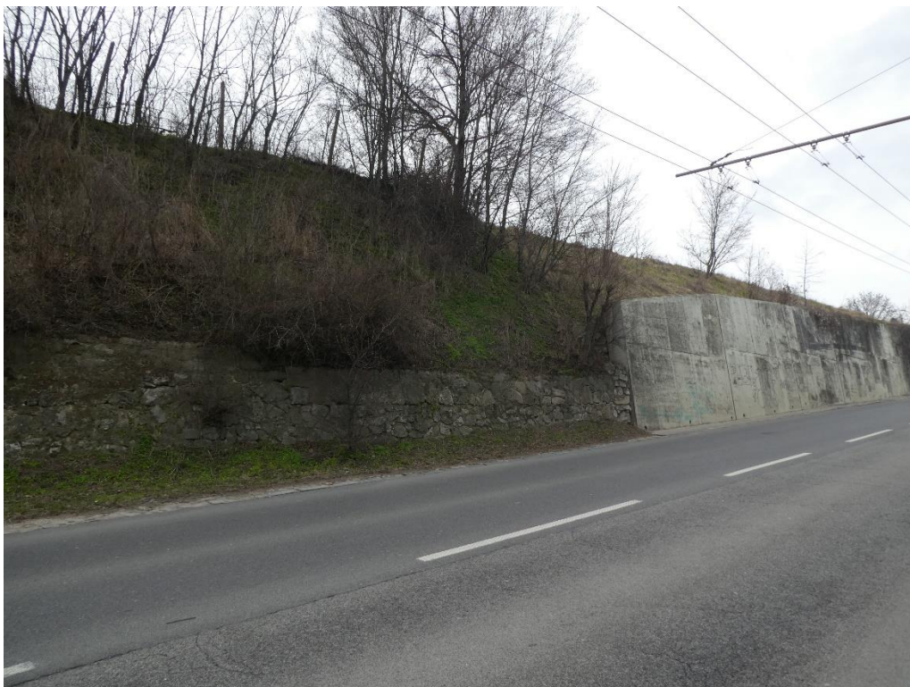
Obr. 20: Napojenie pôvodného múru na nový betónový.
