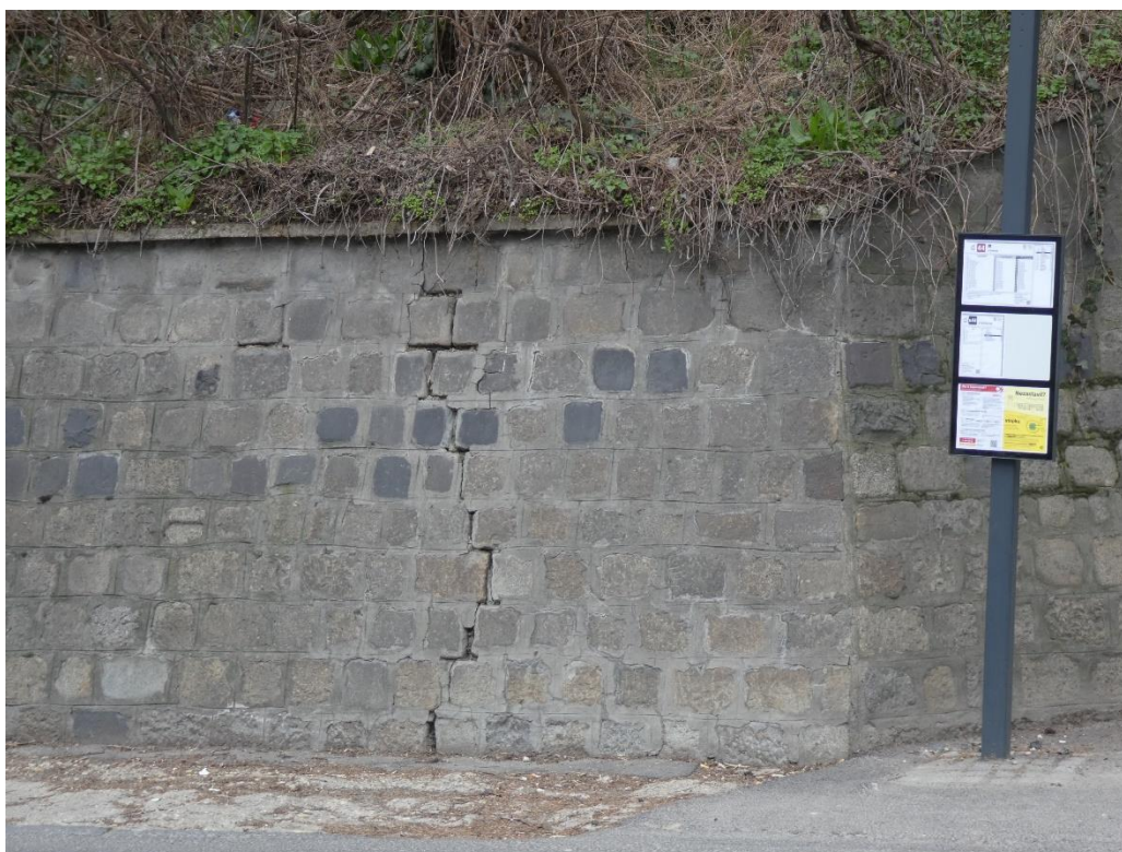
Obr. 11: Vertikálna trhlina
