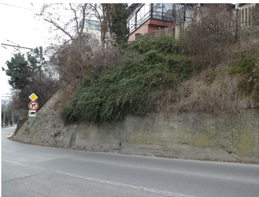
Obr. 18: Prechod z pôvodného múru na betónový.
