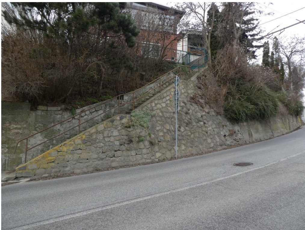
Obr. 17: Začiatok úseku s kamenným schodiskom.
