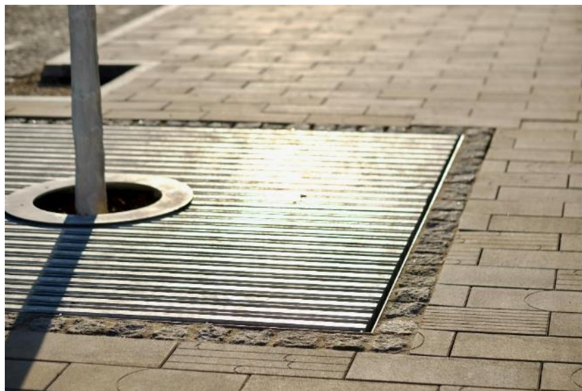
Obrázok 191_Olemovanie stromovej mreže strednou štiepanou dlažobnou kockou – príklad z Mýtnej ulice
