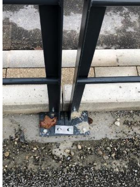
Obrázok 84_Príklad kotvenia zábradlia pod povrchom dlažby - detail
