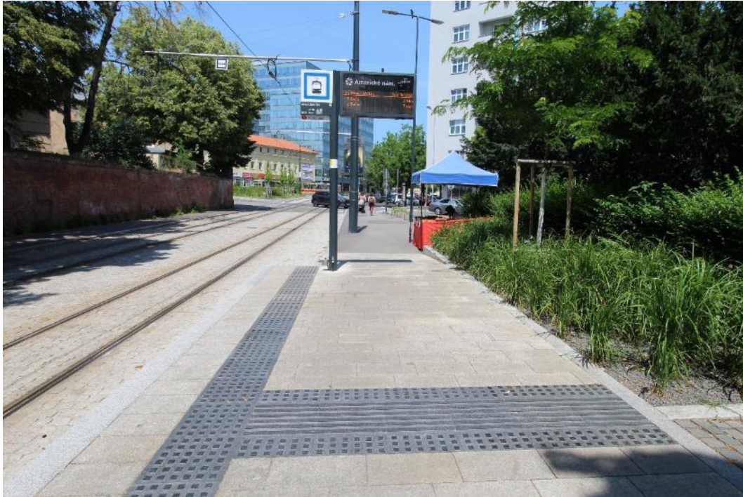
Obrázok 6_Příklad dláždenia povrchov na električkovom nástupišti v Úseku 1 – Americké námestie; dlažba na nástupišti – žulová platňa, varovný a signálny pás – žulová platňa s výstupkami a drážkami, farebnosť Impala, kryt koľajiska – stredná štiepaná dlažbová kocka
