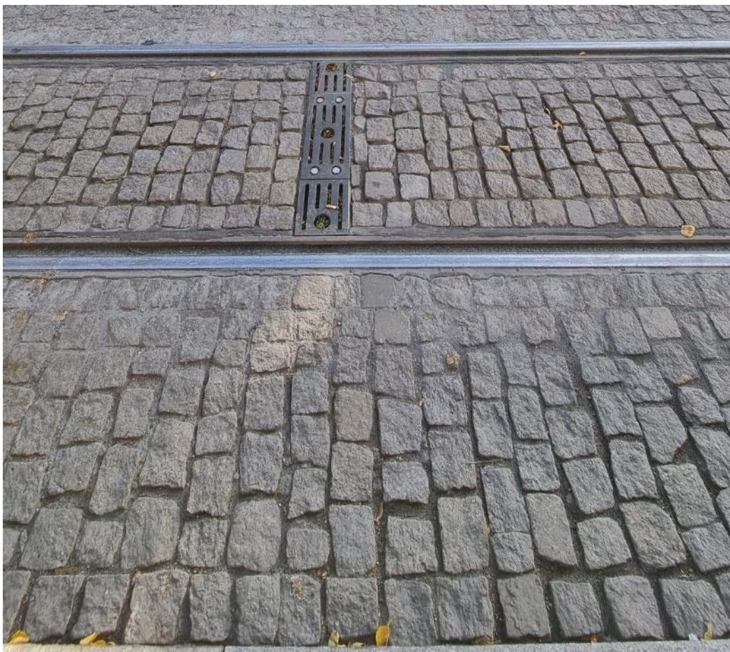
Obrázok 7_Příklad dláždenia koľajiska na jestvujúcej zastávke Americké námestie; stredná štiepaná dlažbová kocka
