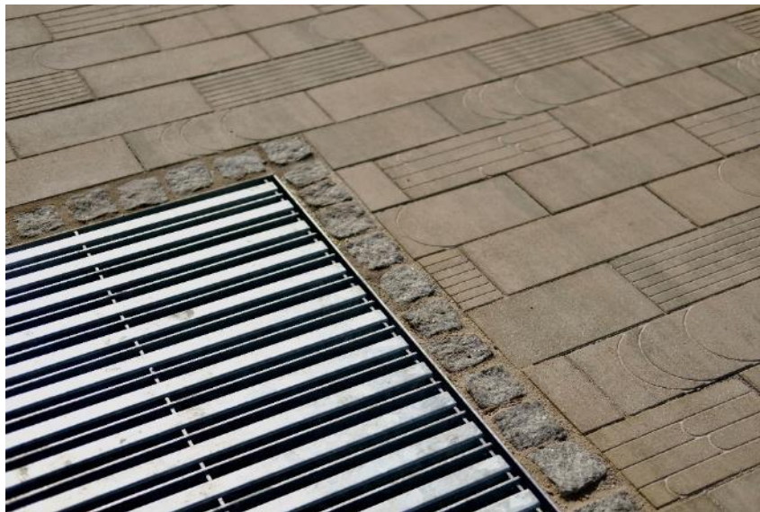
Obrázok 192_Olemovanie stromovej mreže strednou štiepanou dlažobnou kockou – príklad z Mýtnej ulice
