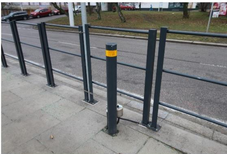
Obrázok 111_Příklad majáčka a nežiadúce riešenie ukoľajnenia
