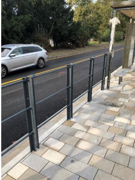
Obrázok 83_Príklad kotvenia zábradlia pod povrchom dlažby
