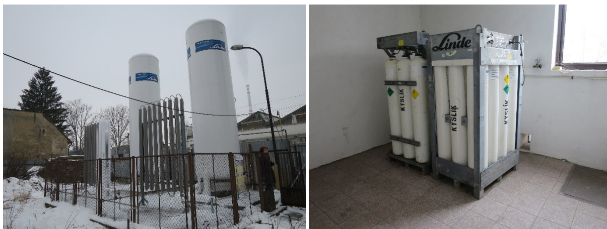
Obrázok 19: Zásobníky s kvapalným kyslíkom (vľavo) a dve záložné súpravy po 12 fliaš (vpravo)
