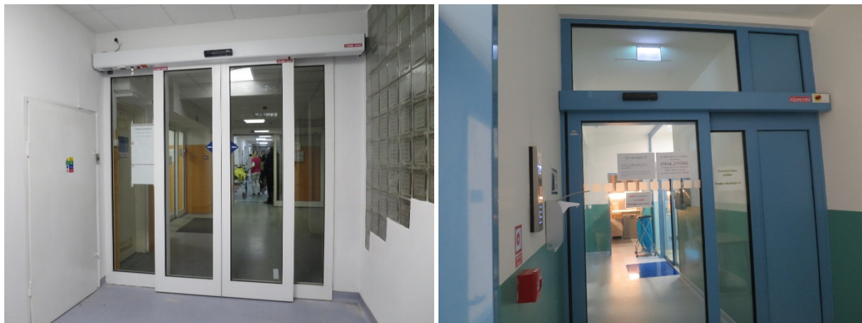
Obrázok 1: Niektoré nové automatické požiarné uzávěry v zrekonštruovaných priestoroch
