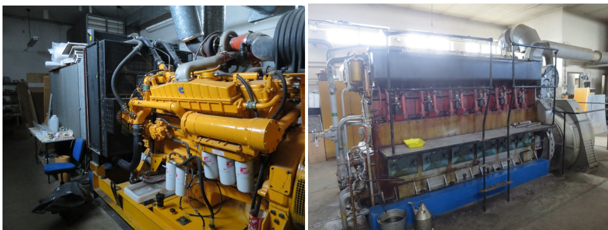
Obrázok 17: Náhradné zdroje - dieselagregáty
