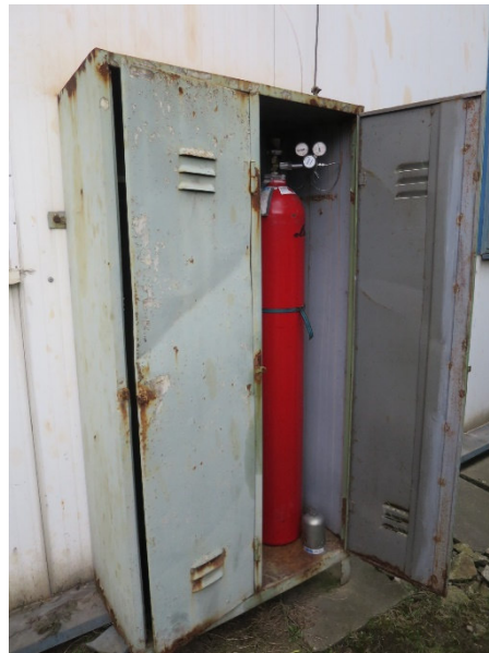
Obrázok 15: Skladovanie vodíka v spaľovni odpadov
