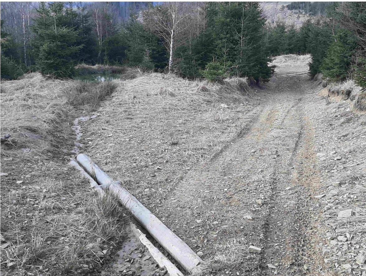
Obr.3. Ukážka dreveneí odrážky na zvažnici so vsakovacou nádržou.
