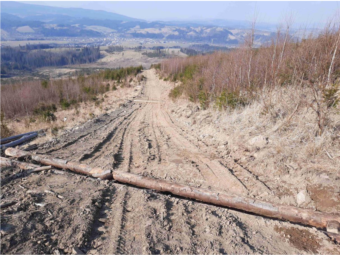
Obr. 2 Ukážka realizovaných drevených odrážok na zvažnici.
