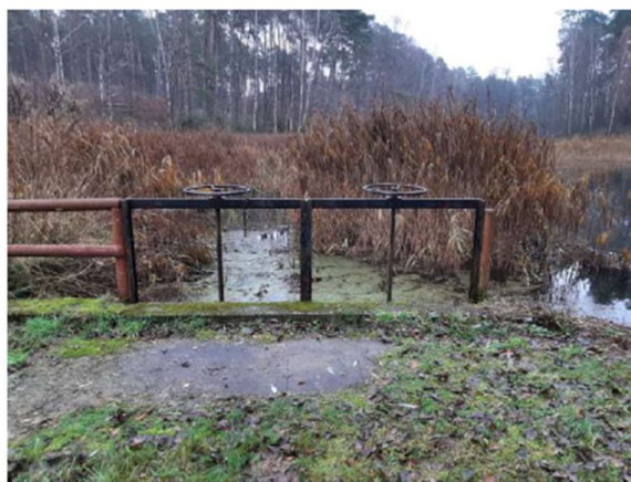
Fot. 2. Wlot do przepustu (nieczynne zasuw) z widokiem na użytek ekologiczny
