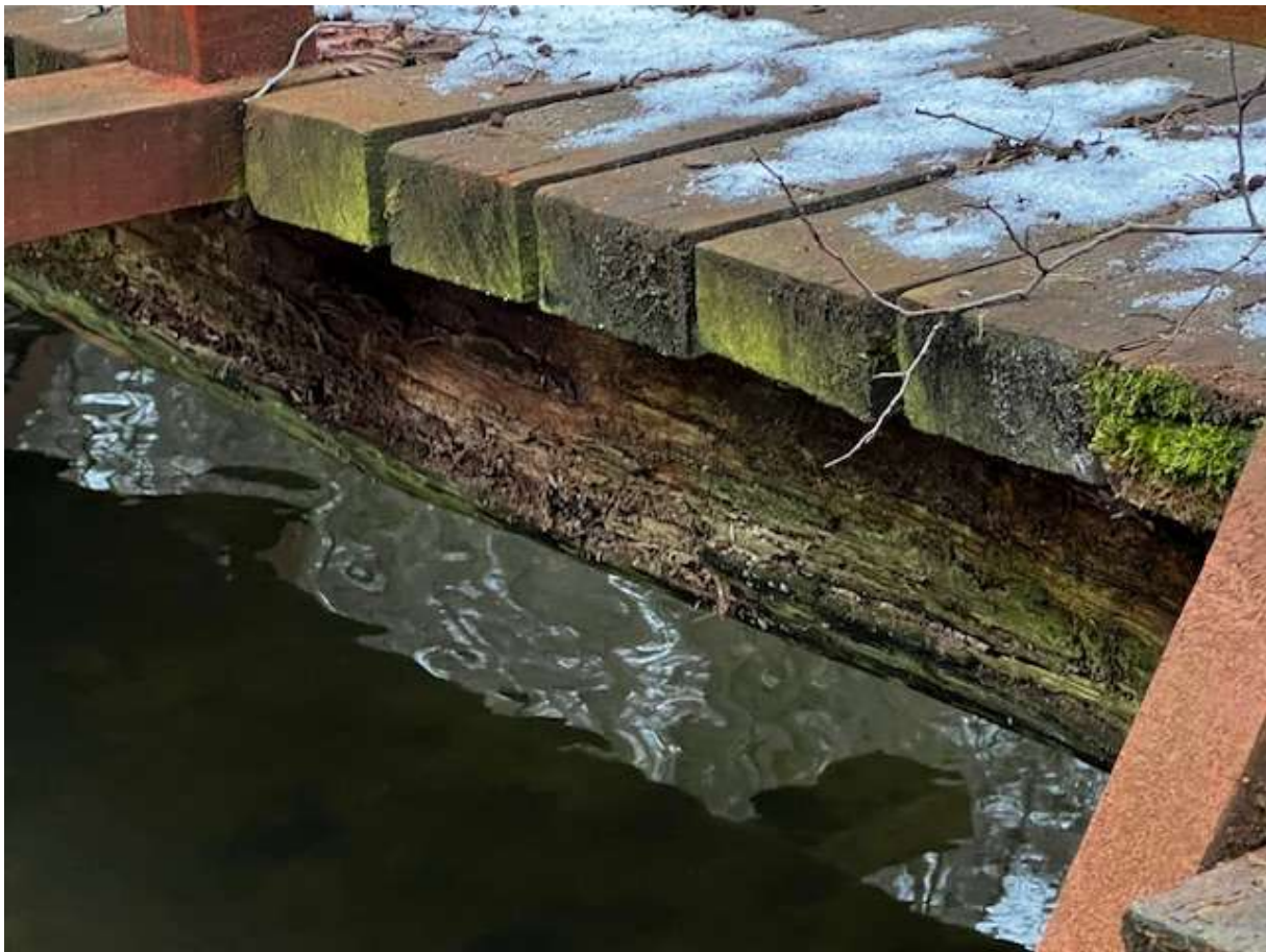
Widok spróchniałej belki nośnej kładki (opracowanie własne)
