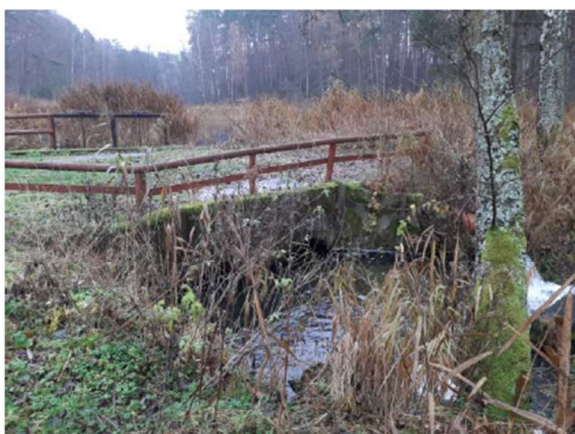
Fot. 3. Przyczółek wylotowy przepustu
