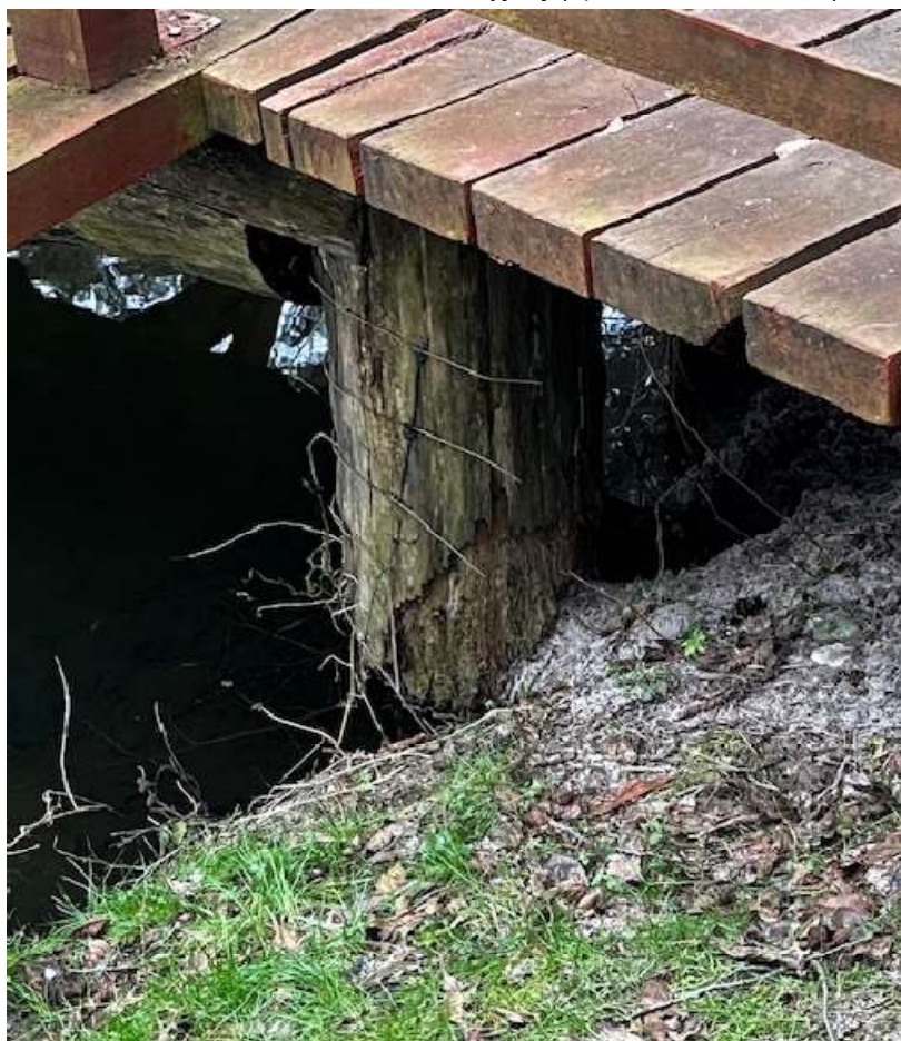
Widok spróchniałego drewnianego pala kładki (pracowanie własne)
