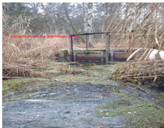
Fot. 5. Wlot do przepustu nieczynne zasuw
