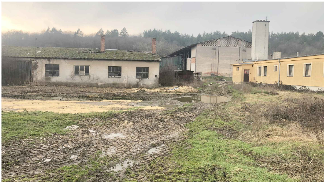
POHĽAD NA PAZCELU Z VÝCHODNEJ STRANY
