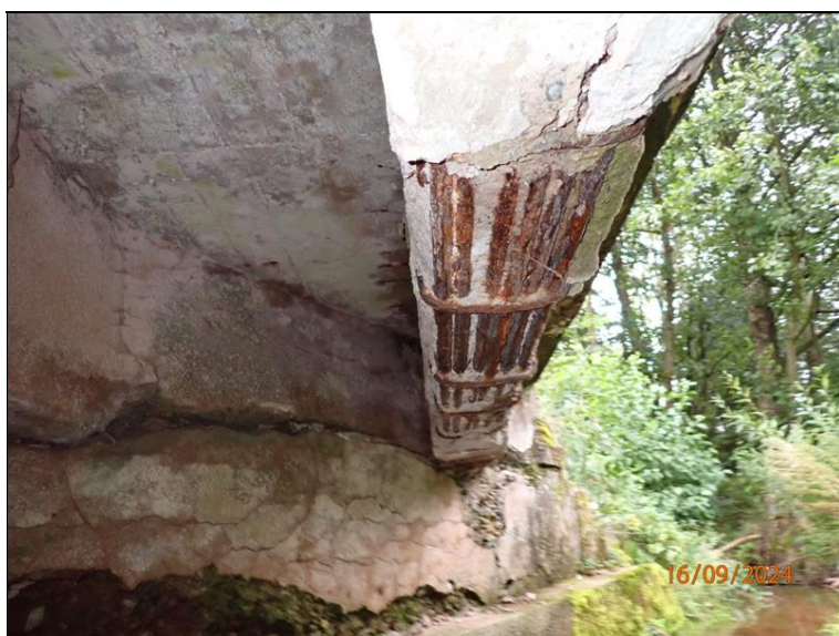
Veliký odštěp betonu a rozsáhlá koroze výztuže na podhledu trámu 1L, pohled směrem k opěře O1.
