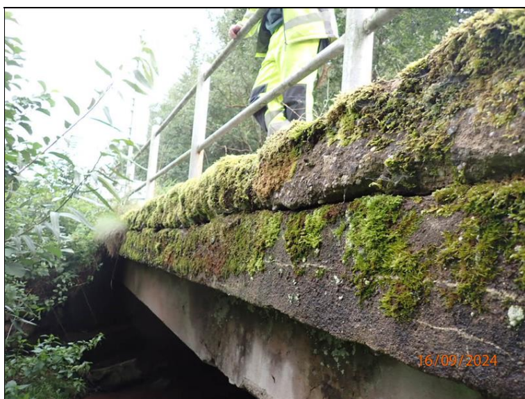
L bok mostu, mrazem degradovaný styk původní a nabetonované římsy.
