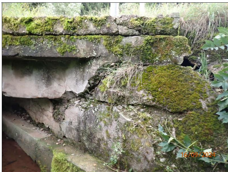
L bok mostu, dřik opěry O1, kaverny následkem mrazového rozpadu betonu.
