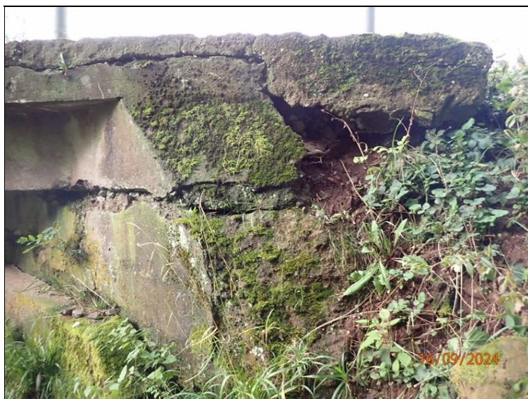
P křídlo opěry O2, vyplavování zeminy zpod konce římsy.
