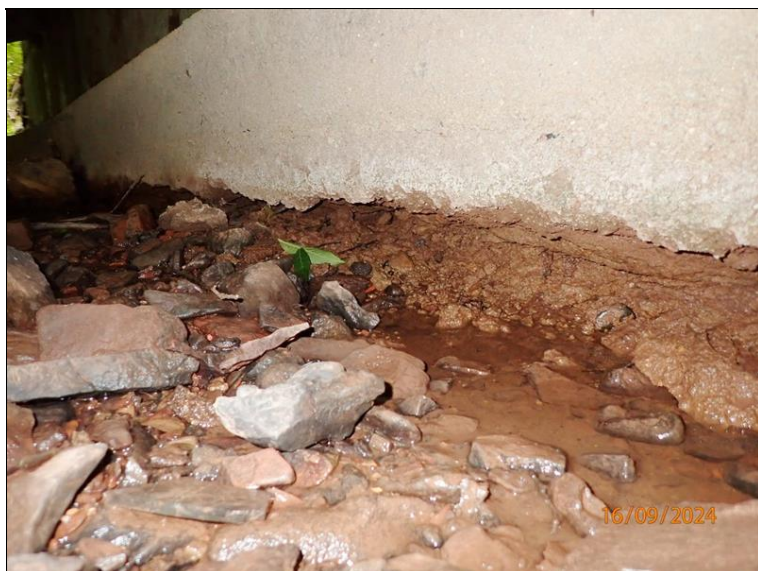
Opěra O2, souvislá kaverna pod betonovým ochranným pasem v líci dříku.
