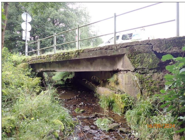
P bok mostu z koryta potoka, nabetonovaná římsa.
