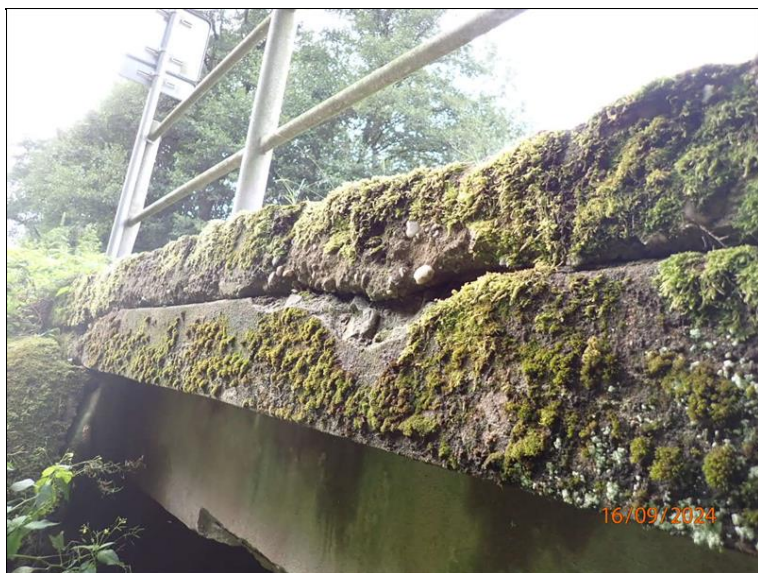
P bok mostu, mrazem degradovaný styk původní a nabetonované římsy.
