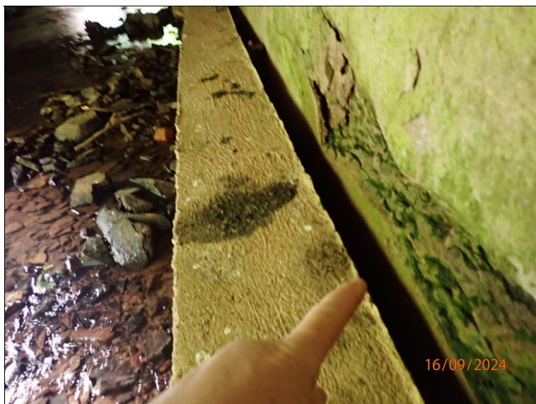
Detail z výše uvedené foto, oddělení ochranného pasu od líce O2.
