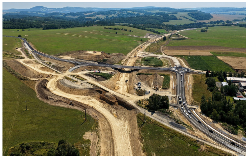
Ředitelství silnic a dálnic pravidelně pořizuje záznamy z budování východního obchvatu Bruntálu. Je z nich patrné, jak stavba postupuje.
