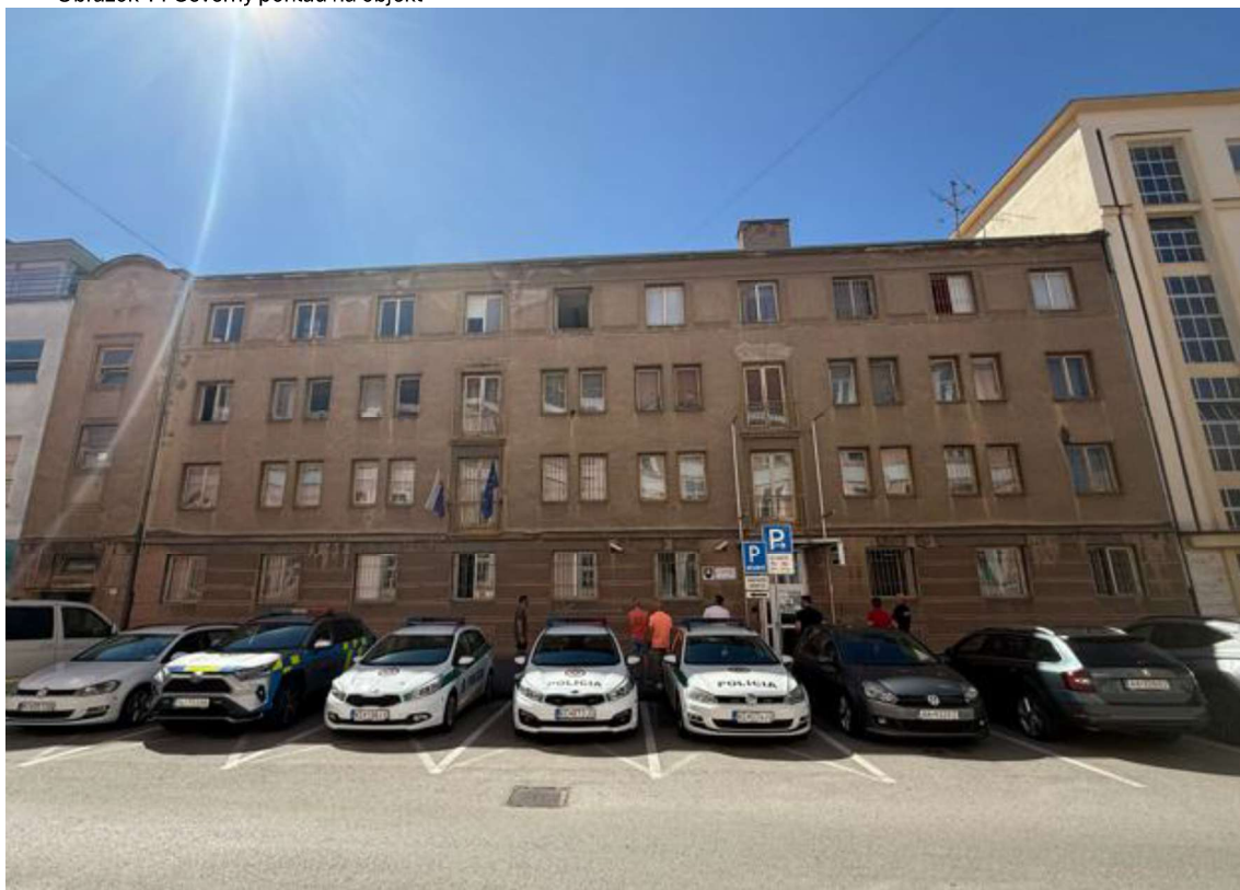
Obrázok 11 Severný pohľad na objekt
