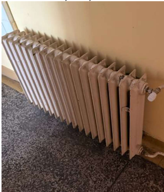
Obrázok 9 Pôvodný liatinový radiátor s ventilom otvor/zatvor (vpravo), doskový radiátor s ventilom otvor/zatvor (vpravo)
