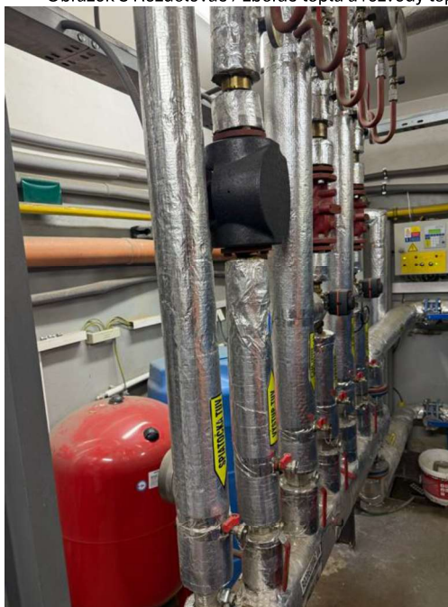
Obrázok 8 Rozdeľovač / zberač tepla a rozvody tepla v priestoroch centrálnej kotolne
