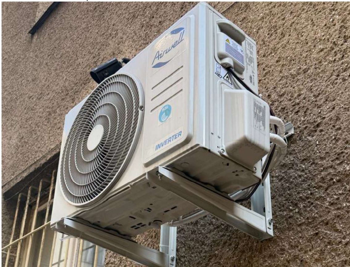
Obrázok 10 Klimatizačná jednotka
