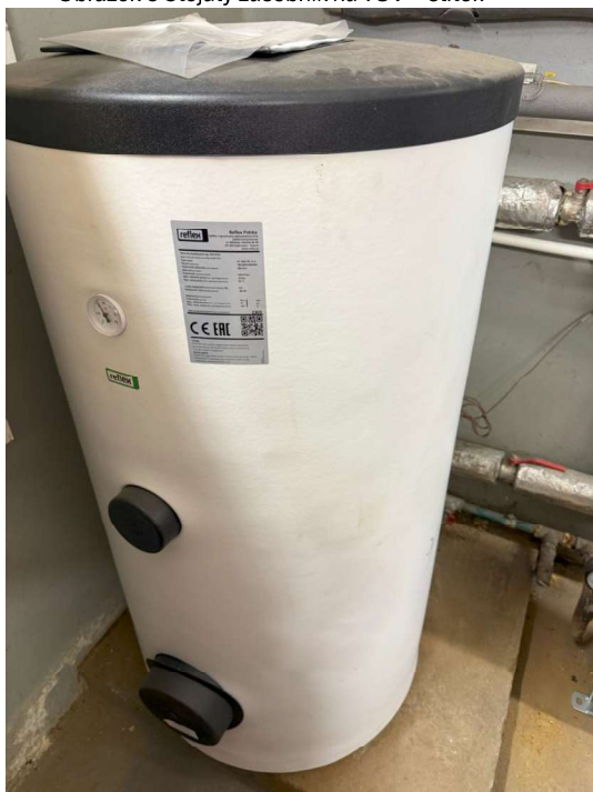
Obrázok 6 Stojatý zásobník na TUV + štítok
