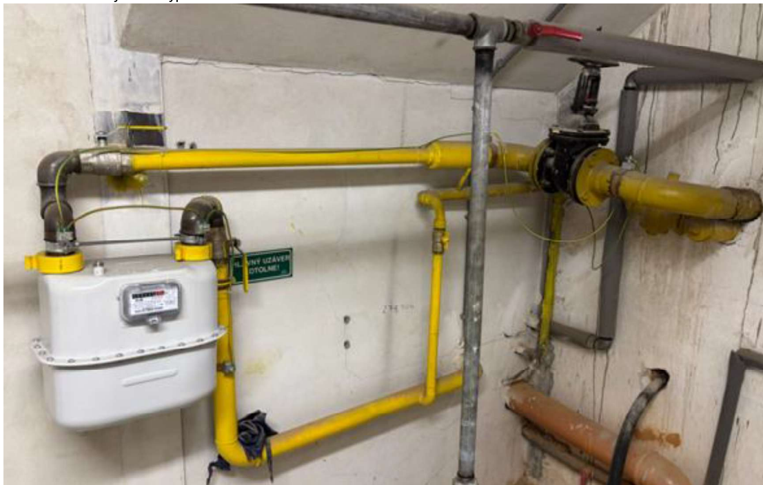
Obrázok 7 Plynomer typu Itron
