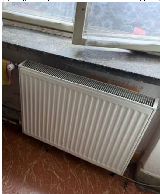
Obrázok 9 Pôvodný liatinový radiátor s ventilom otvor/zatvor (vpravo), doskový radiátor s ventilom otvor/zatvor (vpravo)
