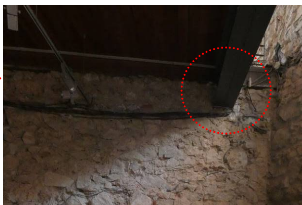
obr.05 Uloženie oc.nosníkov do muriva (príz.)
