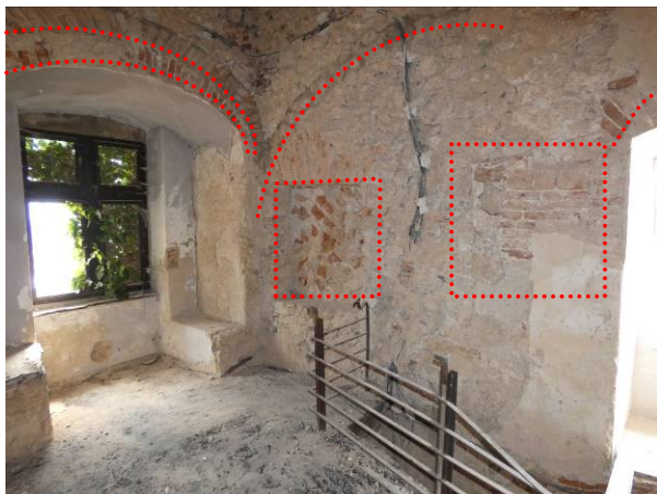
obr.06,07 Stavebné úpravy nosných stien v rôznych obdobiach
