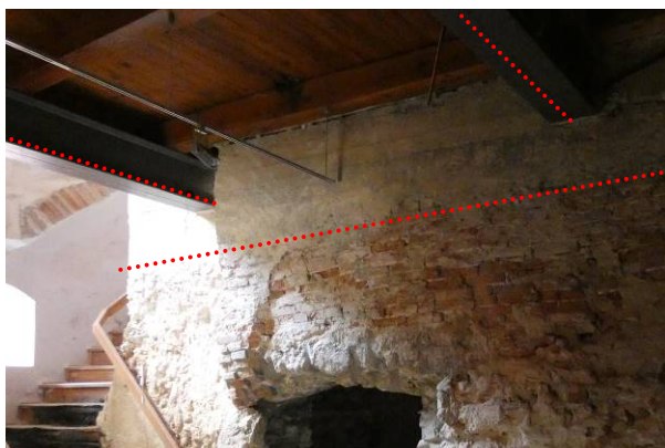
obr.04 Uloženie oc.nosníkov do žb nadstavby (príz.)
