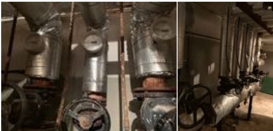
Obrázok 12. Rozdeľovač, zberač
