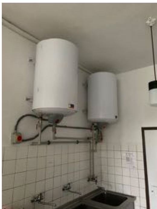
Obrázok 13. Príklady inštalovaných bojlerov.
