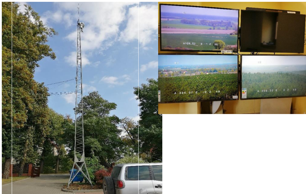
Fot. 2. Stara wieża PAD oraz telewizory pomieszczenie PAD
