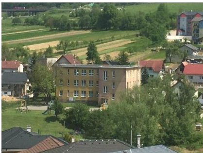
Pohľad na budovu ZŠ a MŠ – zadná strana
