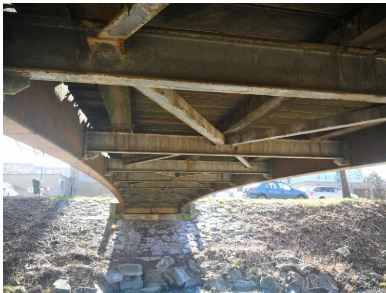
Obr.č.7: Podhled NK – lokální koroze ztužidel.
