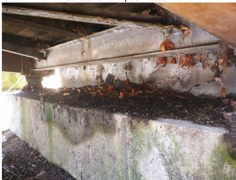
Obr.č.6: Severní opěra – nánosy, nečistoty a zavlhlý úložný práh.
