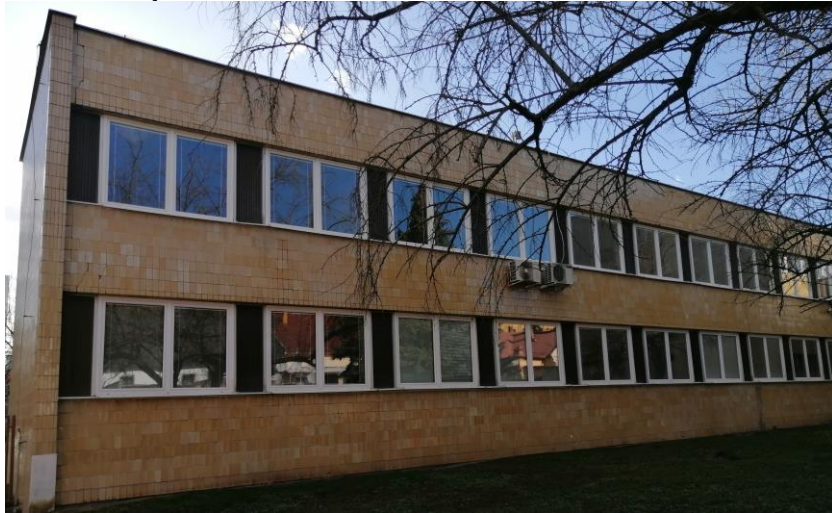
Zadná časť budovy
