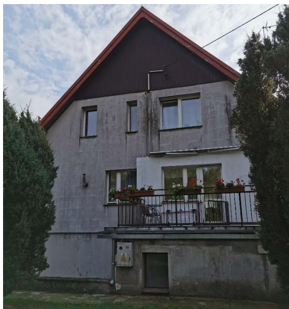
Zdj. nr 3 Elewacja zachodnia - brak wyprawy elewacyjnej
