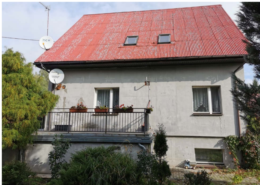
Zdj. nr 2 Elewacja południowa - brak wyprawy elewacyjnej
