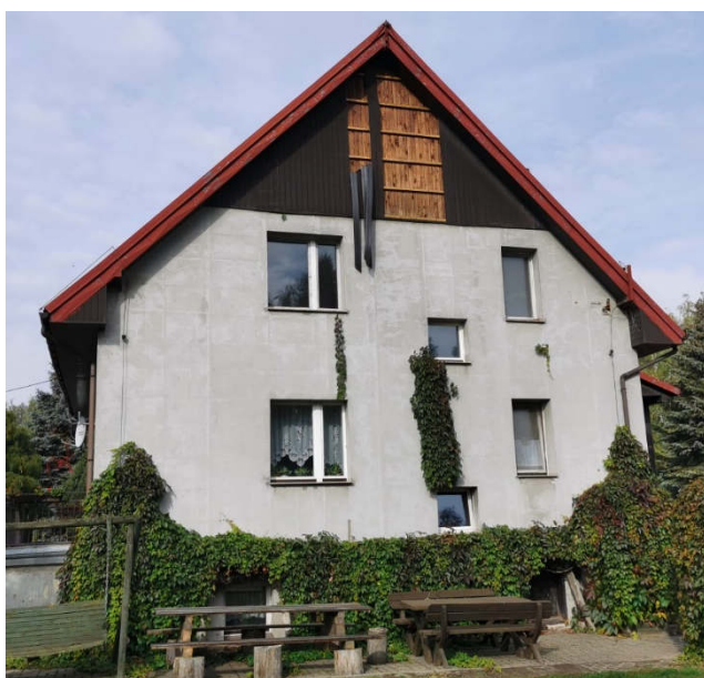
Zdj. nr 1 Elewacja wschodnia - uszkodzona okładzina z paneli siding
