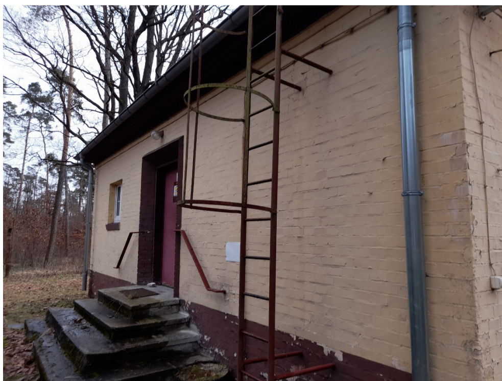
Widok budynku od strony północnej.
