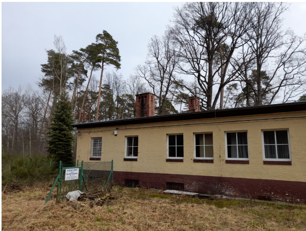
Widok budynku od strony zachodniej.
