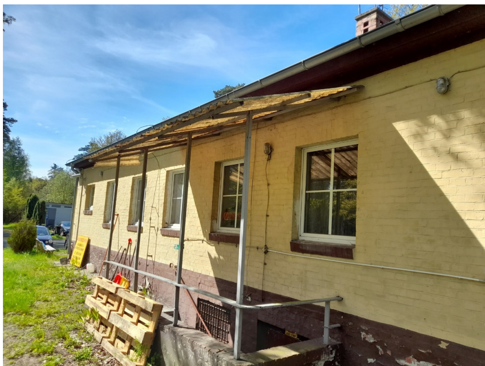
Widok budynku od strony zachodniej.
