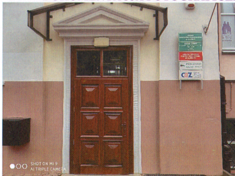
Fot.1. Widok głównego wejścia do budynku o zawężonej szerokości drzwi.
