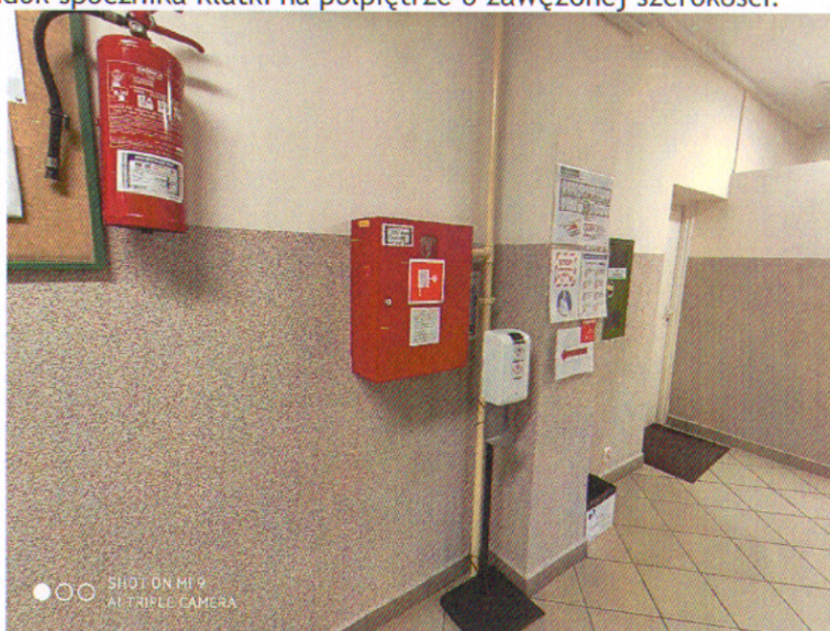
Fot.5. Widok istniejącego hydrantu 25 z węzłem płaskoskładanym - do wymiany i częściowej zmiany lokalizacji / poza wydzieloną pożarowo klatkę schodową/.
