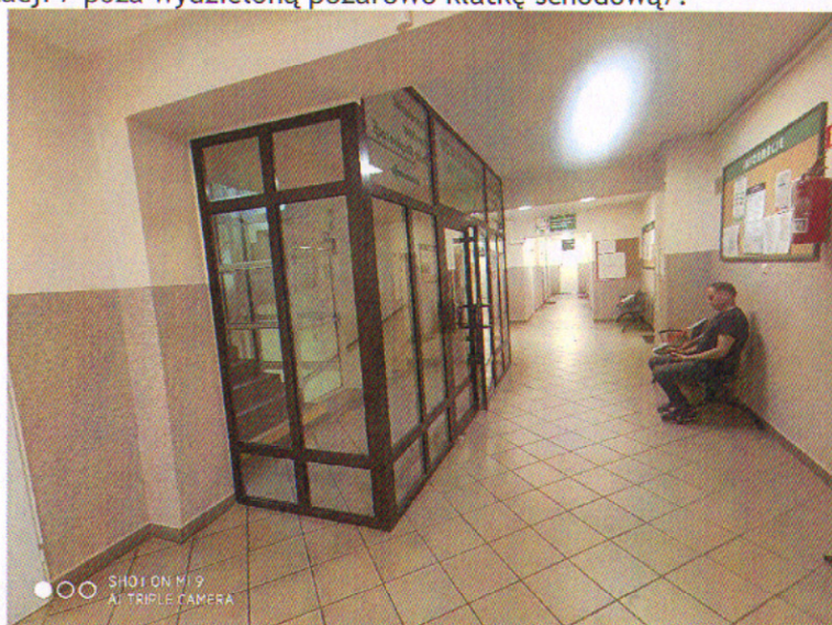
Fot.6. Obudowa bezklasowa klatki schodowej - do wymiany na posiadającą odporność ogniową i wymaganą szerokość drzwi.
