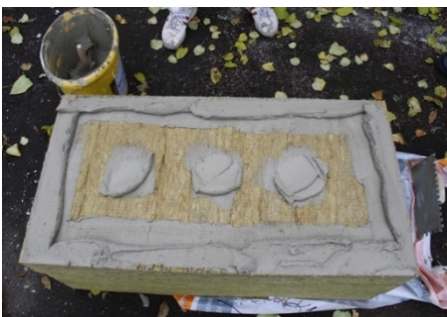
ILUSTRÁČNÁ FOTKA - Ukážka správneho nanesenia lepidla na fasádnú dosku
