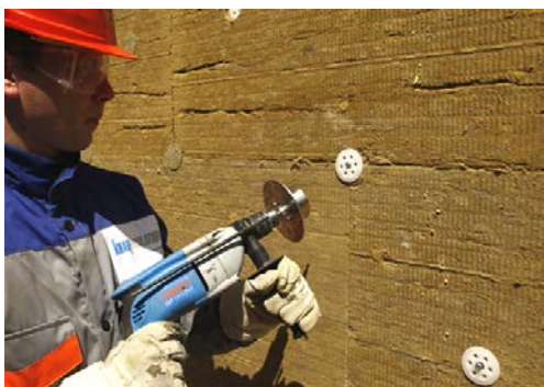
ILUSTRÁČNÁ FOTKA – Ukážka prípravku na montáž zapustených rozperných kotiev
