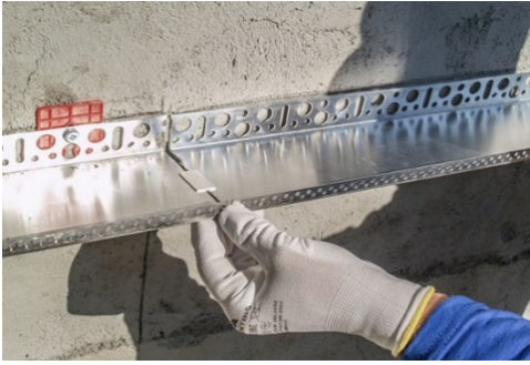
ILUSTRÁČNÁ FOTKA - Správne založenie zkladacej lišty
