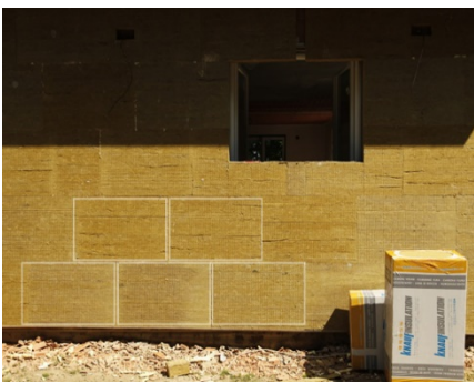
ILUSTRÁČNÁ FOTKA - Ukážka správneho uloženia dosiek na stene
