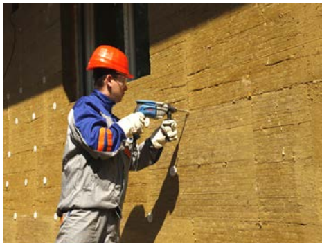
ILUSTRÁČNÁ FOTKA - Ukážka vrtania otvorov - kolmo na stenu
