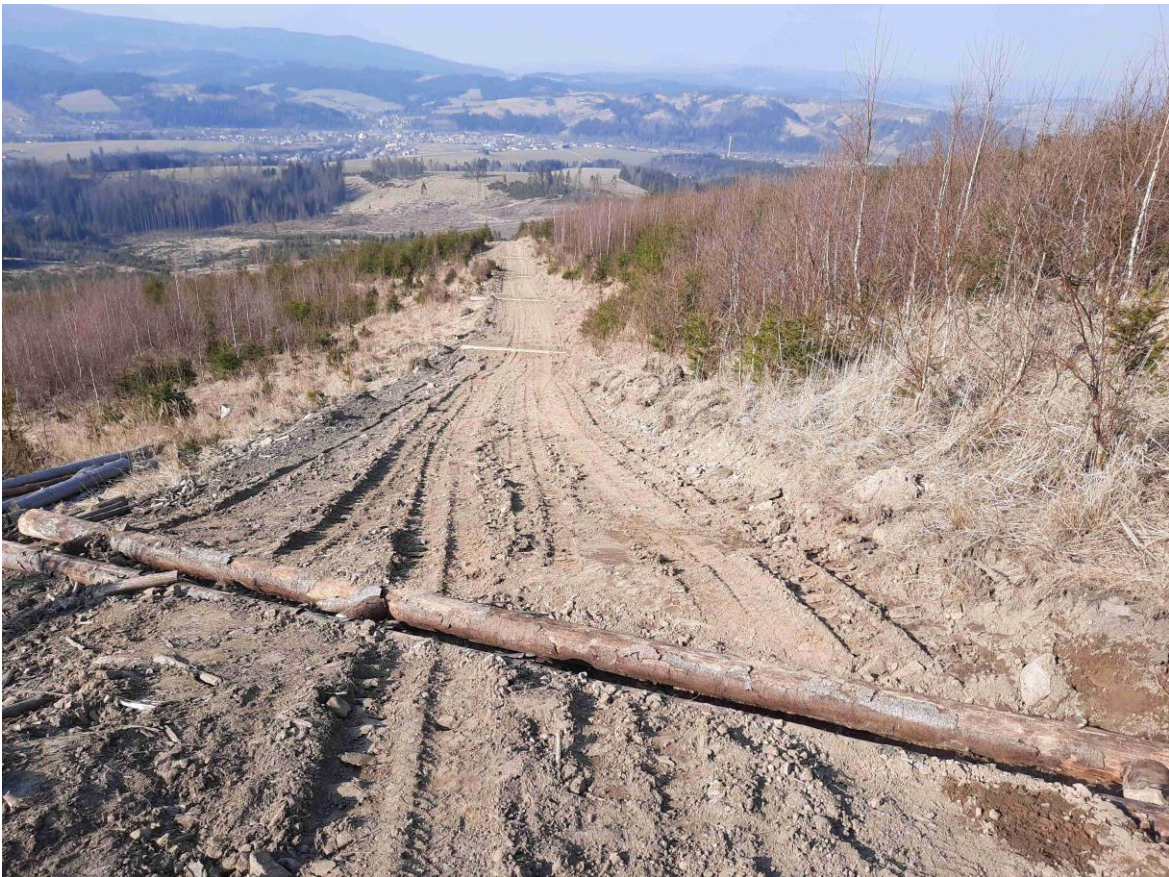
Obr. 2 Ukážka realizovaných drevených odrážok na zväžnici.
