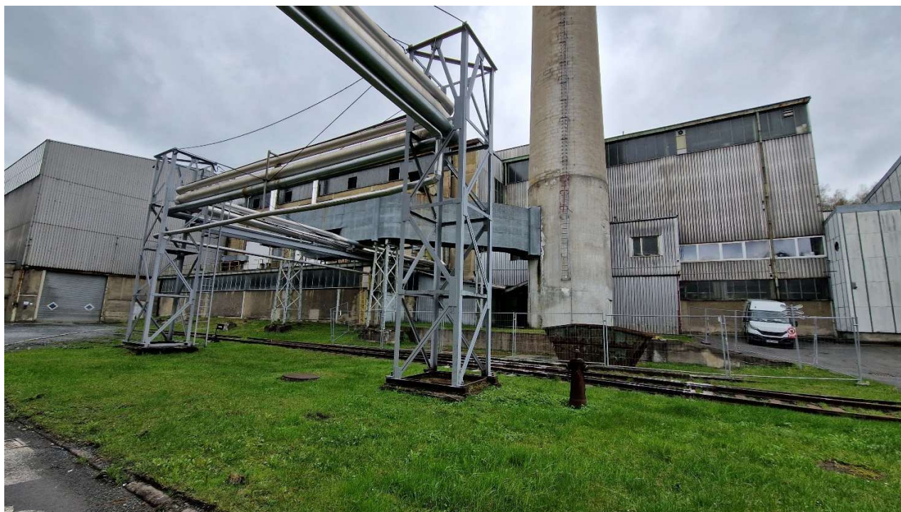
Obr: Kotelna z jižní strany, v popředí potrubní most (voda) a pata komína se spalínovody
