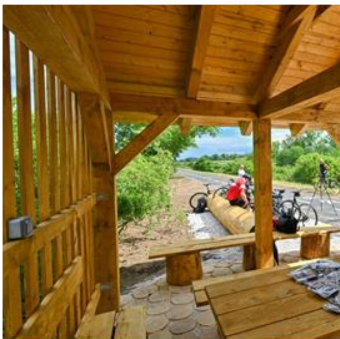
Obr. č. 20. Pohľad vnútri odpočívadla s klátikovou podlahou .
