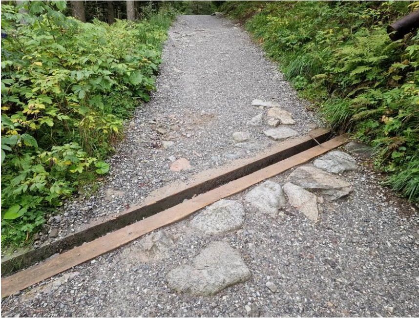
Obr. č.4. Zvodnica na cyklotrase u agátových alebo dubových hranolov 100x100 mm.
