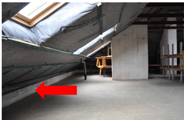
Zdjęcia archiwalne przed przebudową poddasza, pom. nr 2.13 ze wskazaniem wieńców do ocieplenia
