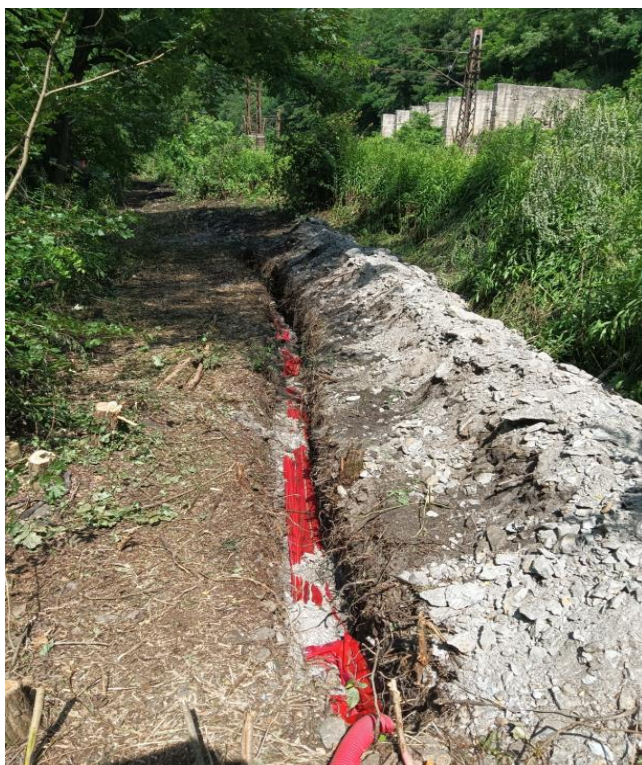
Výkop ryhy a uloženie NN prípojky SO 02-35- 11
