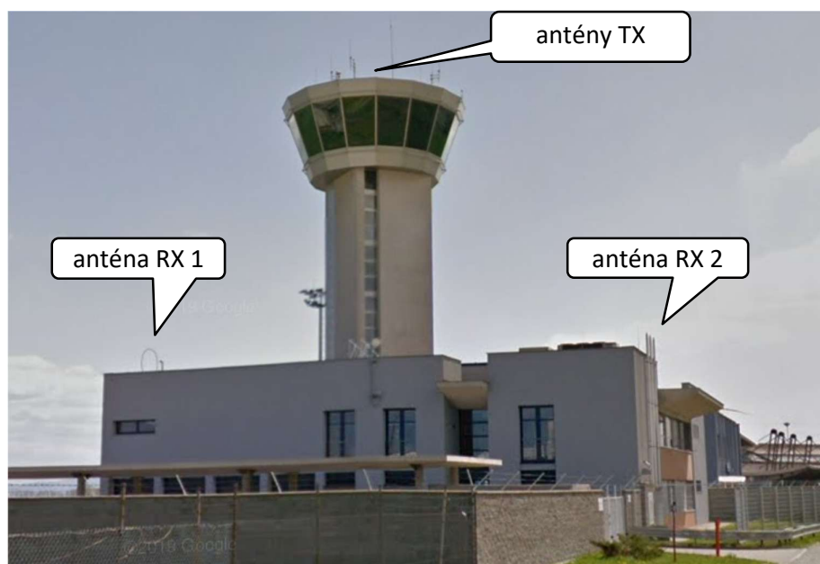
Obrázok č. 4 – Umiestnenie antén na letisku Košice
