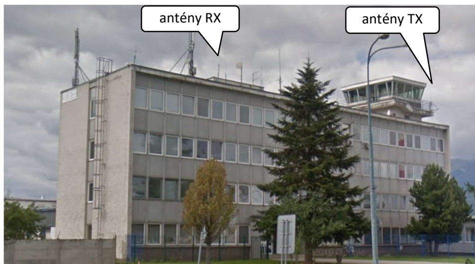
Obrázok č. 3 – Umiestnenie antén na letisku Poprad-Tatry
