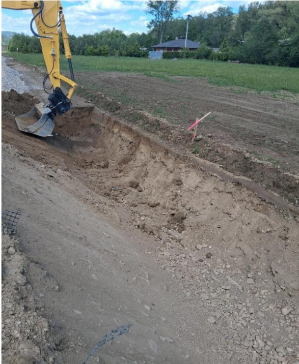
Obrázok č. 5 SO 103 Výkop ryhy pre kamennú pätku opevnenia telesa komunikácie km 19,900
