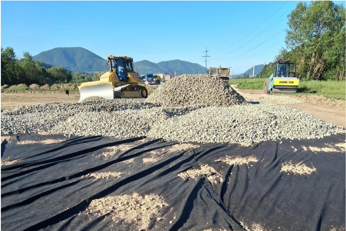
Obrázok č. 3 Realizácia geodosky typ 3 km 21,400
