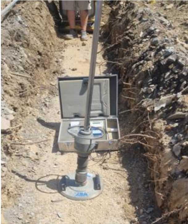
Obrázok č. 8 SO 520 Dynamická skúška na lôžku pre potrubie prepadovej kanalizácie
