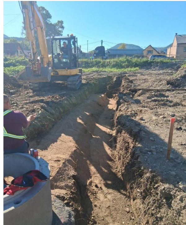
Obrázok č. 9 SO 520 Realizácia lôžka pre potrubie
