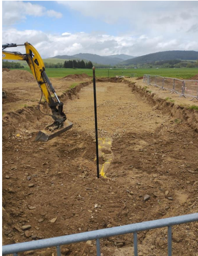
Obrázok č. 12 SO 794 Finalizácia spätného zásypu
