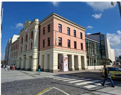
1. Budova DJGT-pohľad z Námestia SNP
