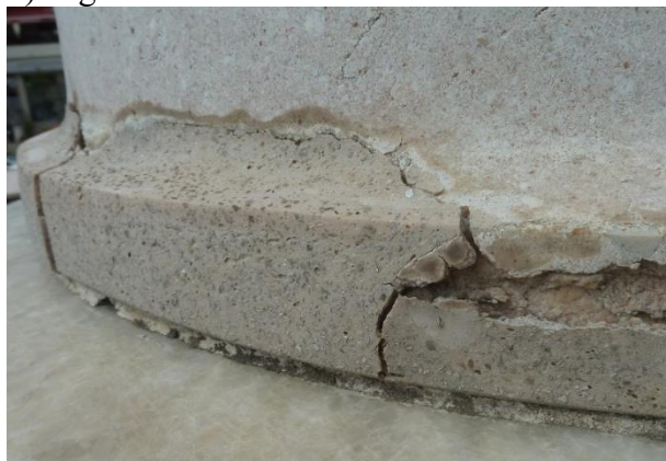
d) degradace tmelů
