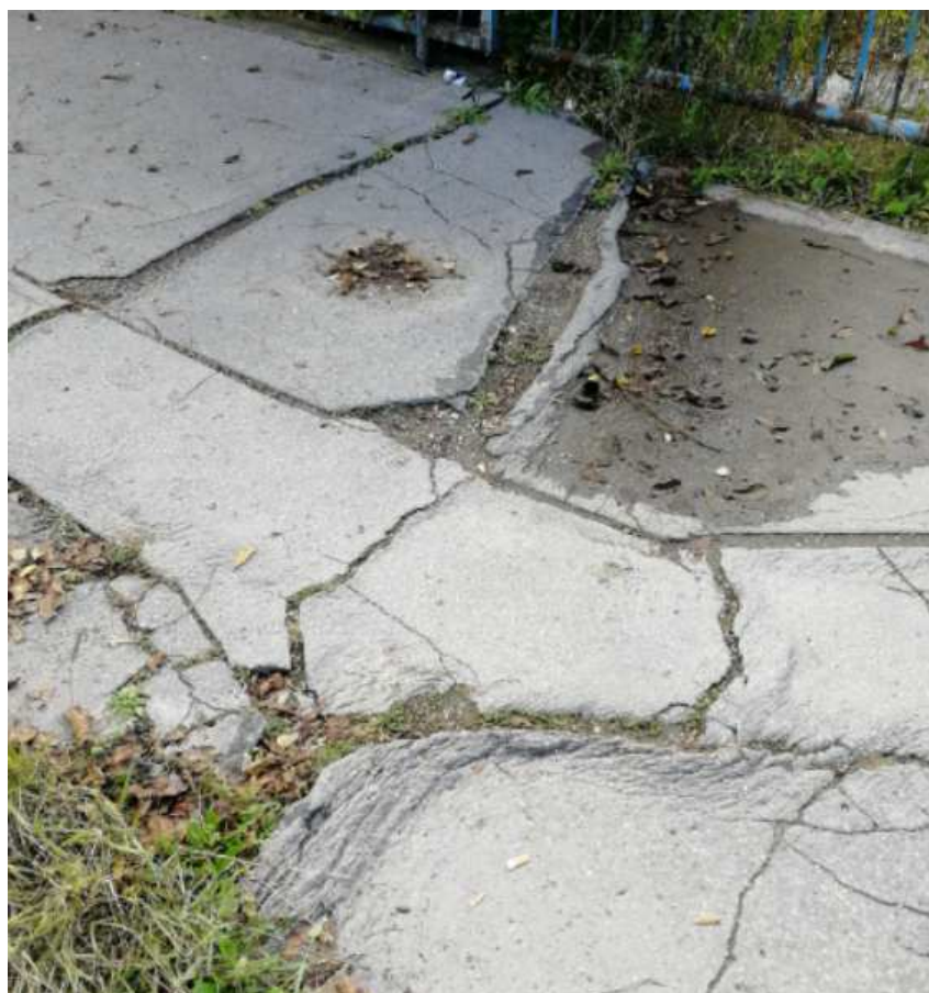
Obr. 10: Popraskaná a zdeformovaná vozovka v časti prechodovej dosky
