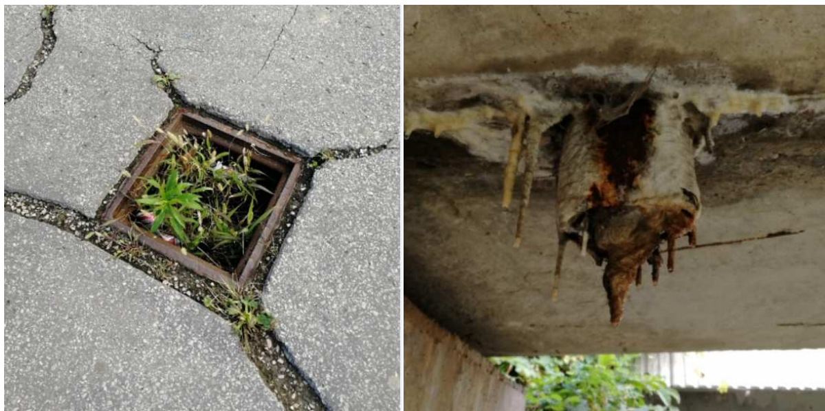
Obr. 11: Upchaný odvodňovač
