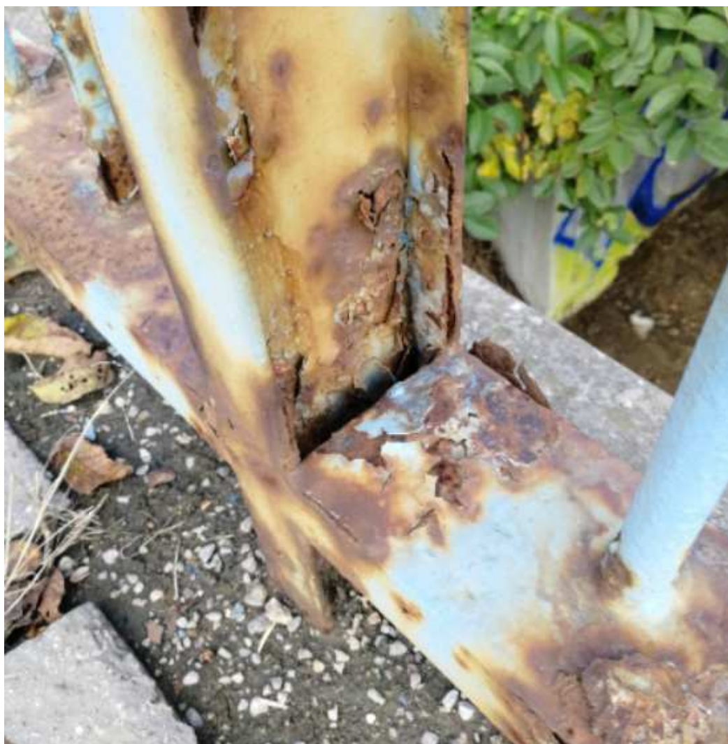
Obr. 12: Korózia na prvkoch zábradlia
