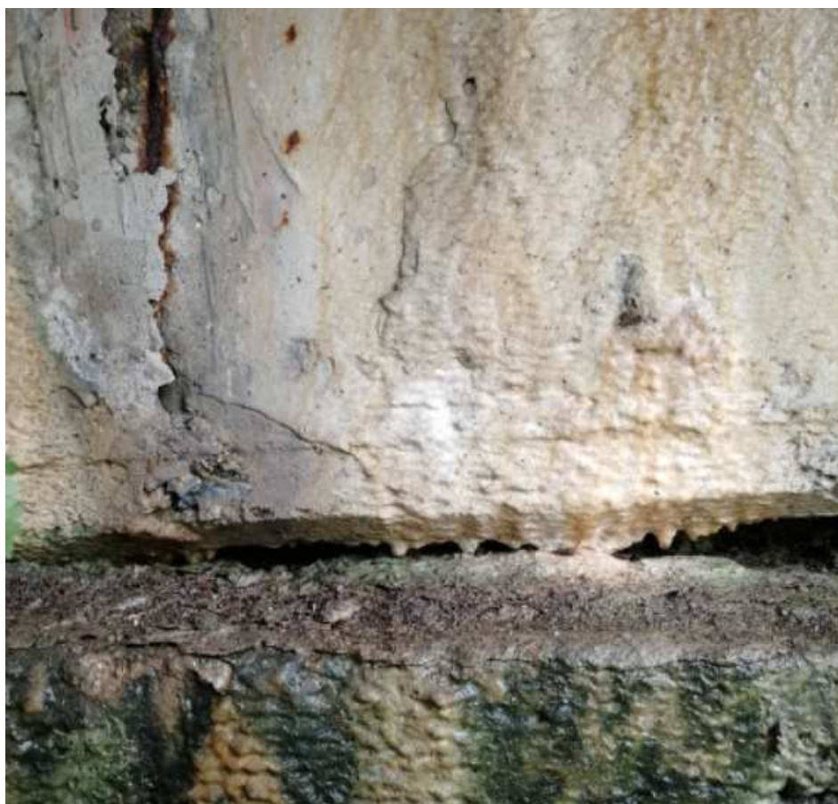
Obr. 08: Nefunkčná vodotesnosť mostných záverov
