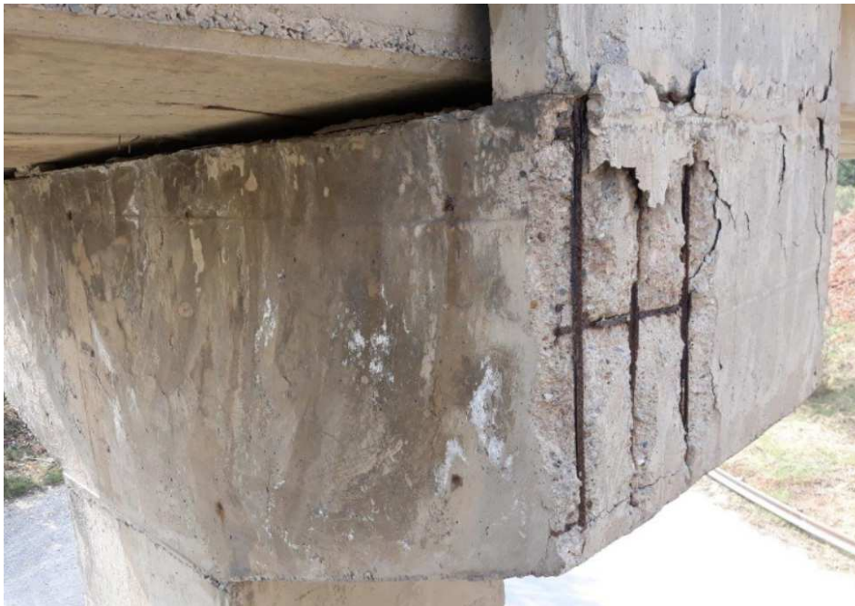
Obr. 07: Obnažená výstuž na čele priečnika
