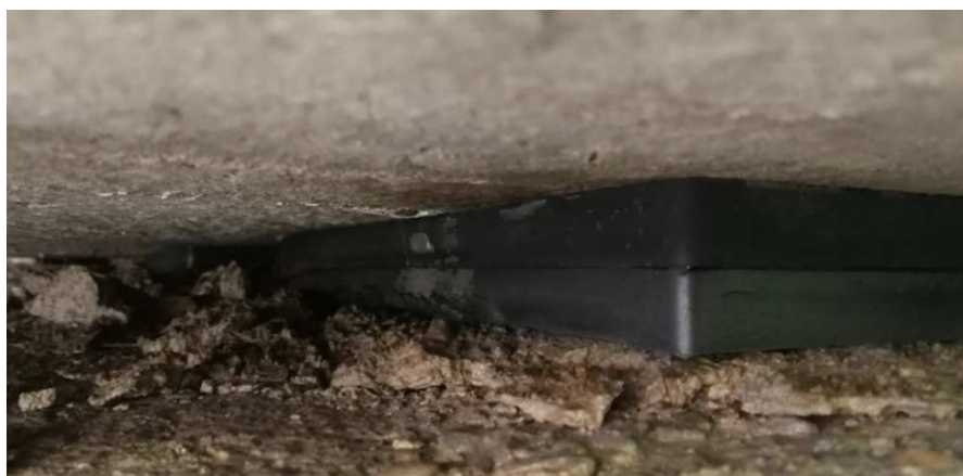
Obr. 02: Detail uloženia nosníkov - ložisko
