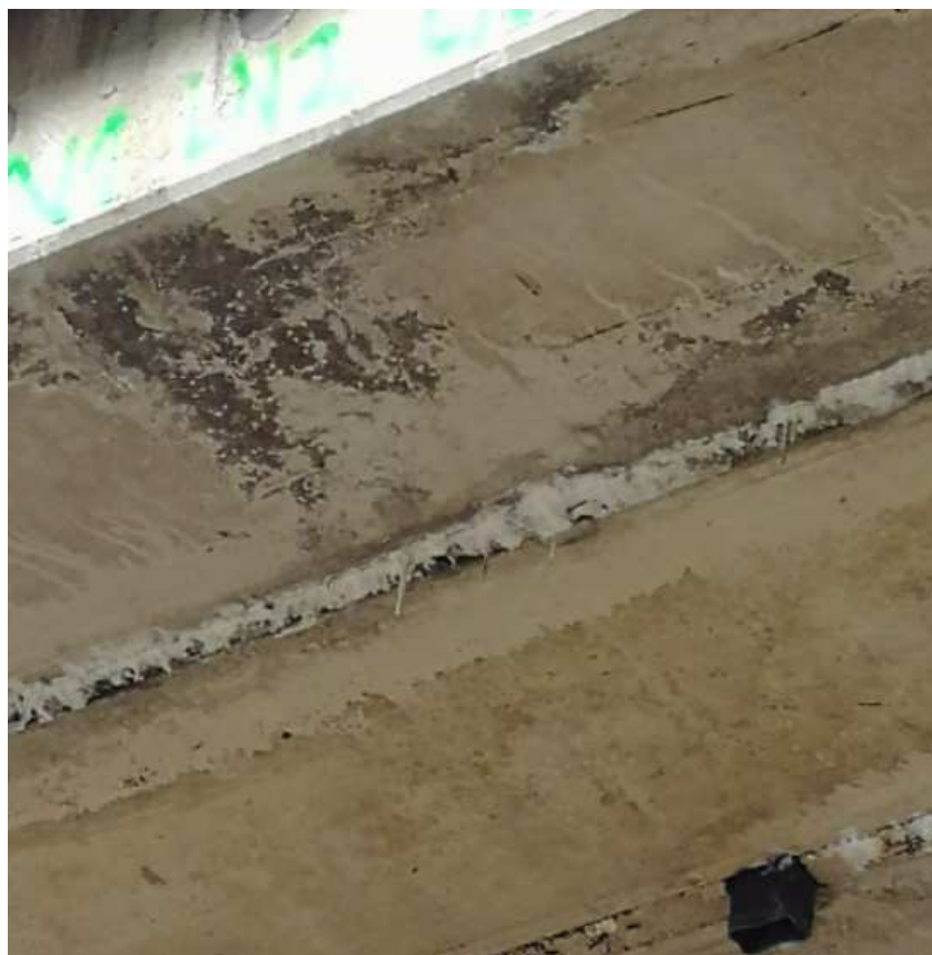
Obr. 09: Nefunkčná hydroizolácia mostovky – výkvetý na nosníkoch
