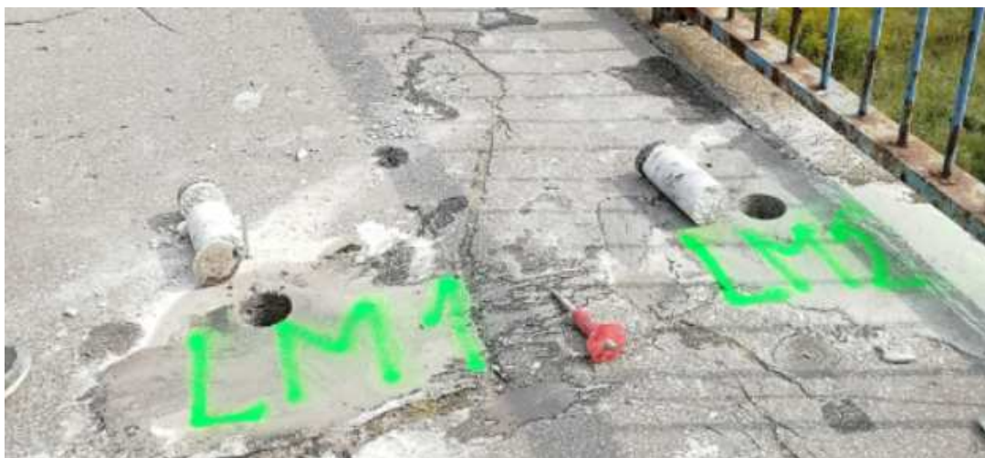
Obr. 04: Poloha jadrových vývrtov na mostovke.
