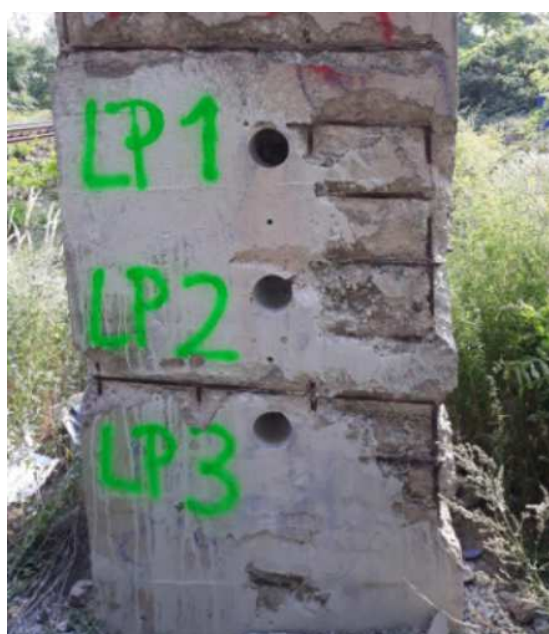
Obr. 03: Miesta realizácie jadrových vývrtov, zhora: nosník, vľavo: krajná opora, vpravo: medziľahlá opora.
