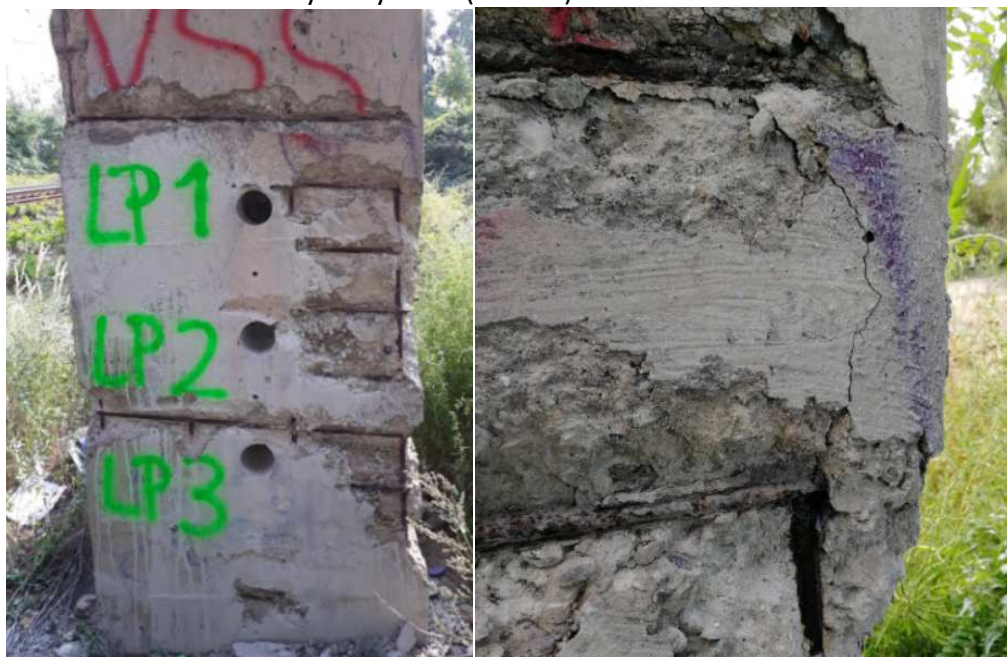
Obr. 05: Obnažená výstuž na opore
