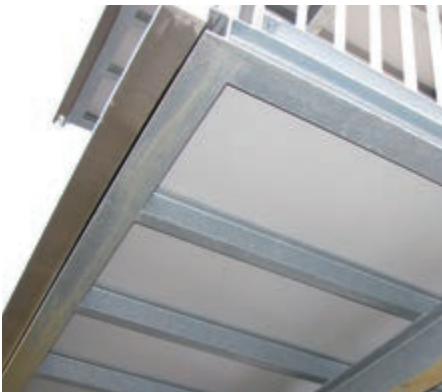
SPODNÍ KONSTRUKCE / NOSNÍKY
