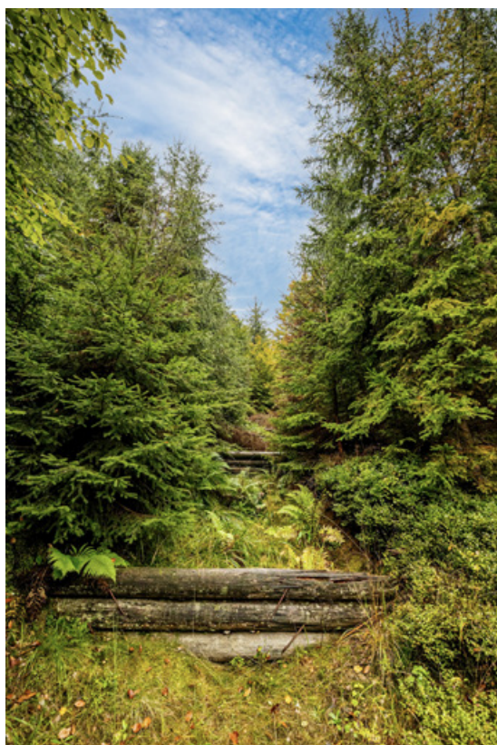
Fot. 103. Typowa zabudowa szlaków zrywkowych z wykorzystaniem belek drewnianych w Nadleśnictwie Wiśła (fot. J. Smarczewski, 2021)
