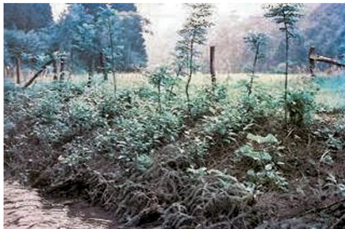
Fot. 68. Brzeg umocniony warstwą chrustu i sadzonkami wierzbowymi [Begemann i Schiechl 1999]
