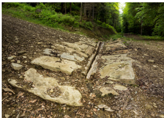
Fot. 107. Wodospust odprowadzający wodę z drogi do lasu, Nadleśnictwo Łosie (archiwum CKPŚ)
