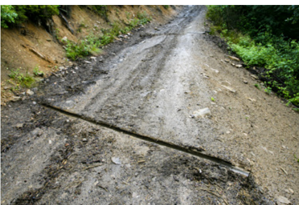
Fot. 108. Wodospust wykonany z pojedynczego okrągłaka, Węgierska Górka (fot. L. Książek)
