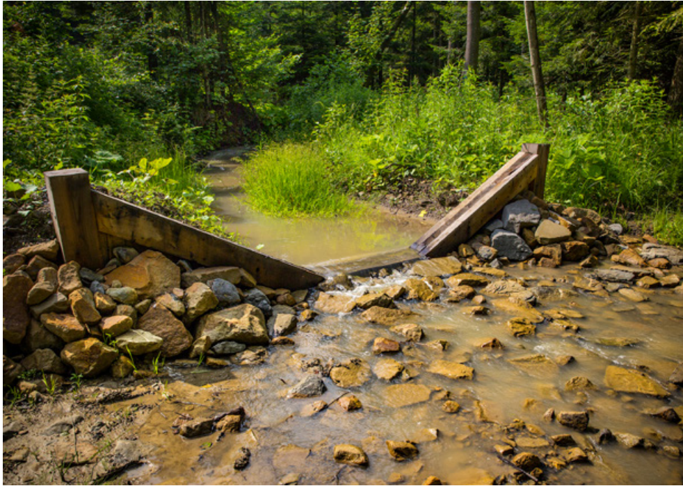
Fot. 37. Prawdłowo ubezpieczone stanowisko górne i dolne progu z pojedynczą ścianką szczelną, Nadleśnictwo Strzyżów (archiwum CKPŚ)
