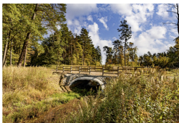
Fot. 141. Nowoczesne konstrukcje odporne na zatkanie rumoszem, Nadleśnictwo Lubaczów (fot. J. Smarczewski, 2021)
