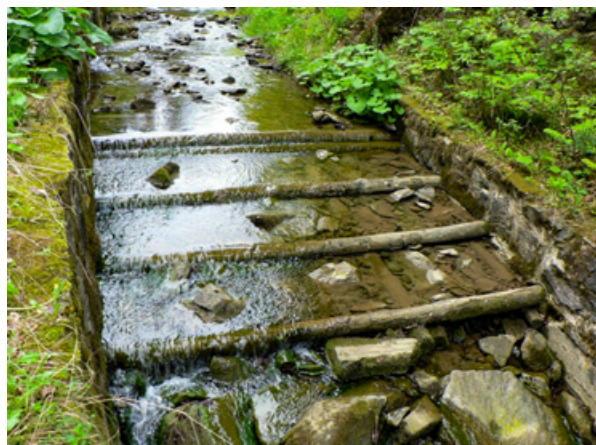
Fot. 129. Kaskada bardzo niskich progów, łątwa do pokonania dla organizmów wodnych, brak przelewów na małą wodę (fot. T. Kowalik)
