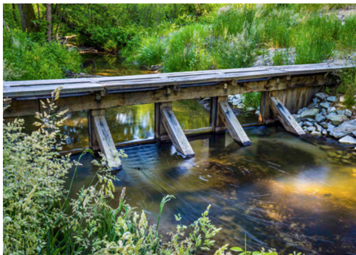
Fot. 35. Jaz zastawkowy z kilkoma przęsłami i szandorami w Nadleśnictwie Sieraków (fot. J. Smarczewski, 2023)
