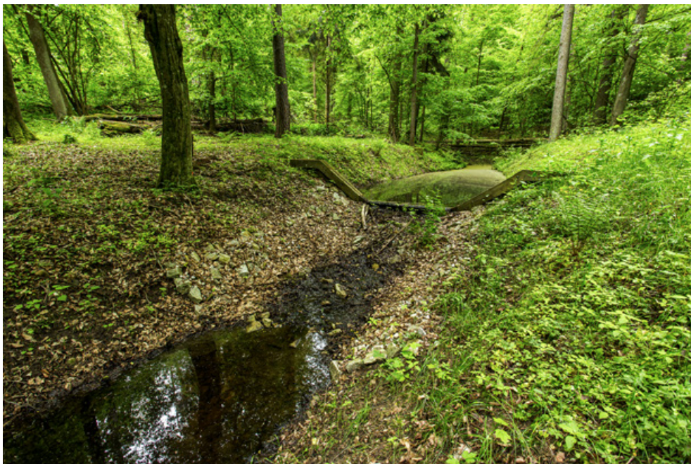
Fot. 38. Piętrzenie stałe – ścianka szczelna podparta bystrzem w Nadleśnictwie Maskulińskie, 2015 (archiwum CKPŚ)
