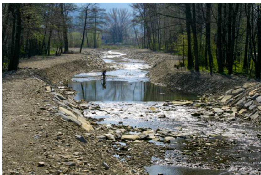
Fot. 98. Bystrze regularne na rzece Targaniczanka (fot. L. Książek, 2010)
