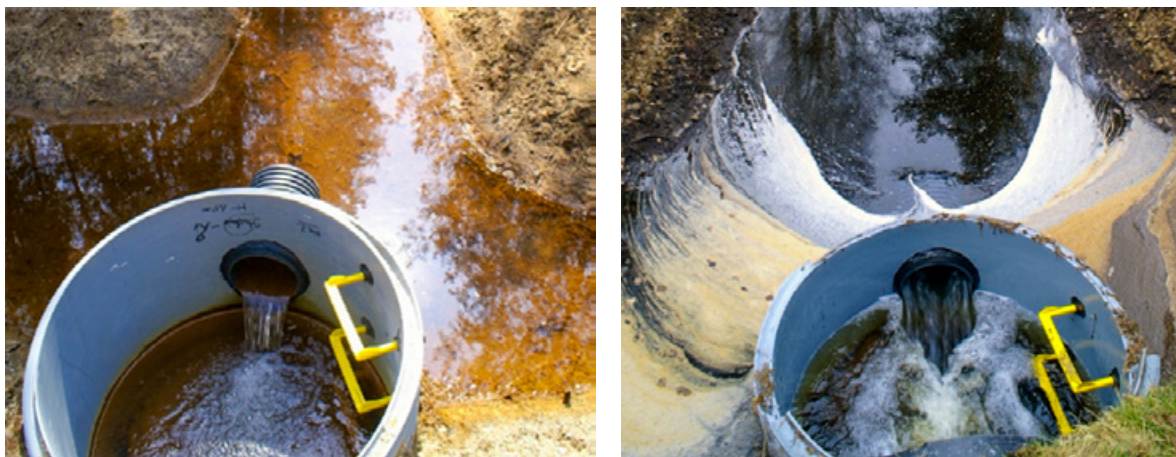
Fot. 58. i Fot. 59. Opóźniacze odpływu na rowach w Nadleśnictwie Ruszów (fot. R. Majewicz)
