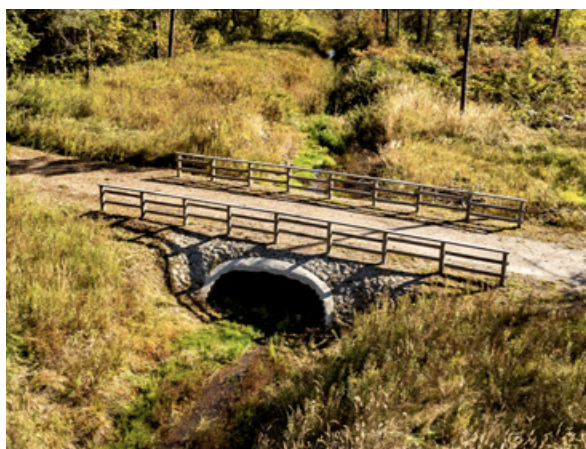
Fot. 94. Przepust/most z naturalnym dnem w Nadleśnictwie Lubaczów (fot. J. Smarczewski, 2021)
