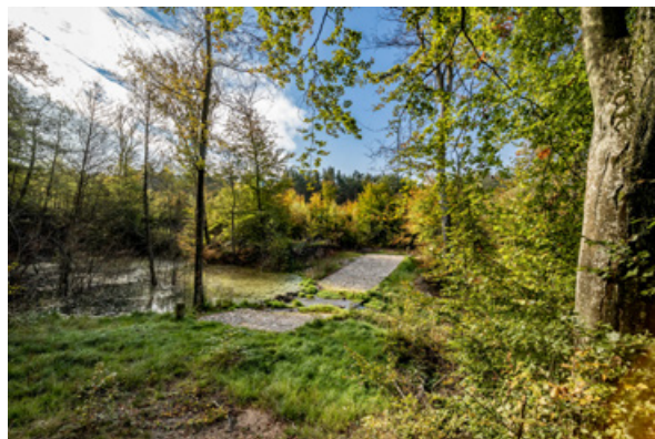
Fot. 92. Bród piętrzący, którego funkcją jest także zatrzymanie wody na obszarach mokradłowych, Choczewo (fot. J. Smarczewski, 2021)
