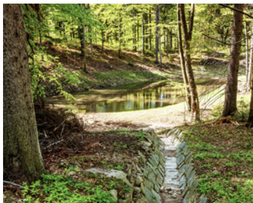
Fot. 14. Zbiornik zasilany spływami powierzchniowymi, w tym korytem kierującym wodę z wysokościzny lub drogi w Nadleśnictwie Piwniczna, 2015 (archiwum CKPŚ)
