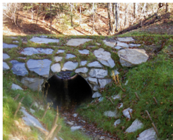
Fot. 97. Przepust umocniony kamieniem łamanym z nasadzeniami w korycie w Nadleśnictwie Komańcza [ https://komancza.krosno.lasy.gov.pl/projekty-i-fundusze ]
