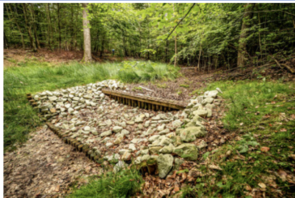
Fot. 45. Próg drewniany z umocnieniem kamiennym w Nadleśnictwie Polanów (fot. J. Smarczewski, 2021)
