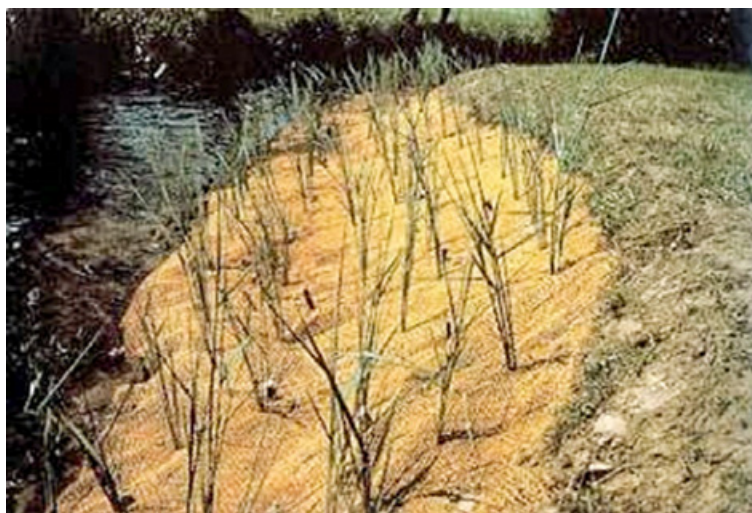
Fot. 71. Umocnienie z siatki jutowej z sitowiem i sadzonkami pędowymi [Begemann i Schiechtl 1999]
