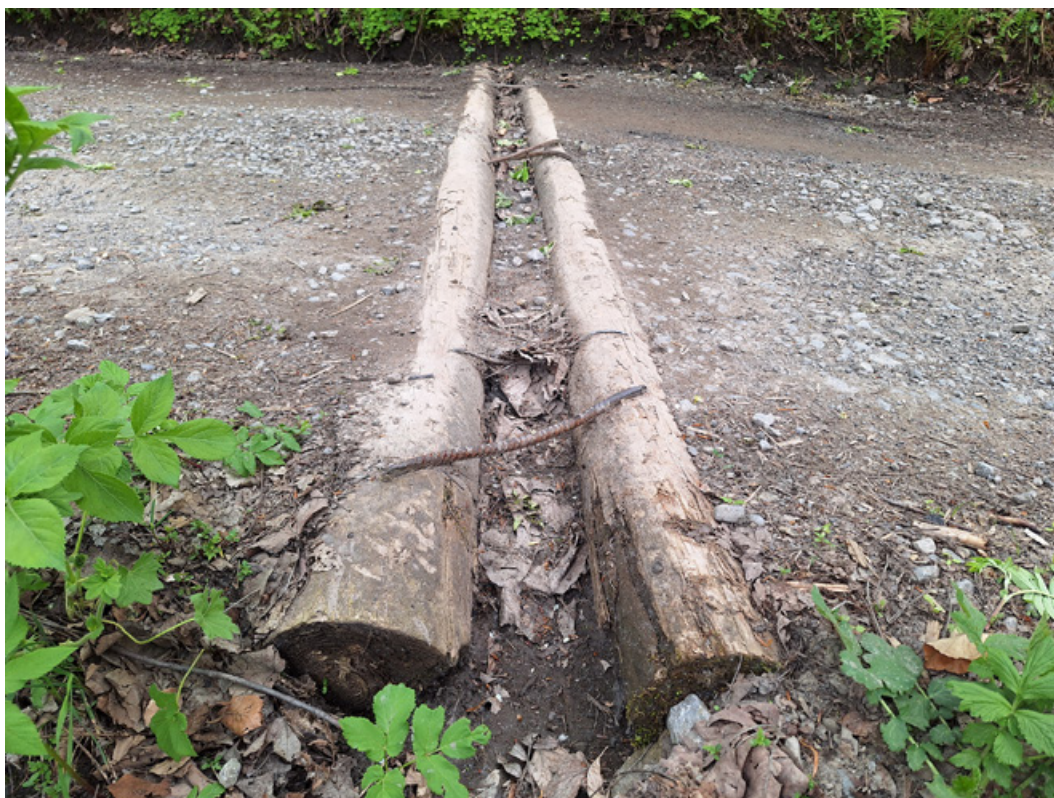
Fot. 110. Wodospust z kłód drewnianych, Nadleśnictwo Wiśta (fot. J. Lasota, 2025)
