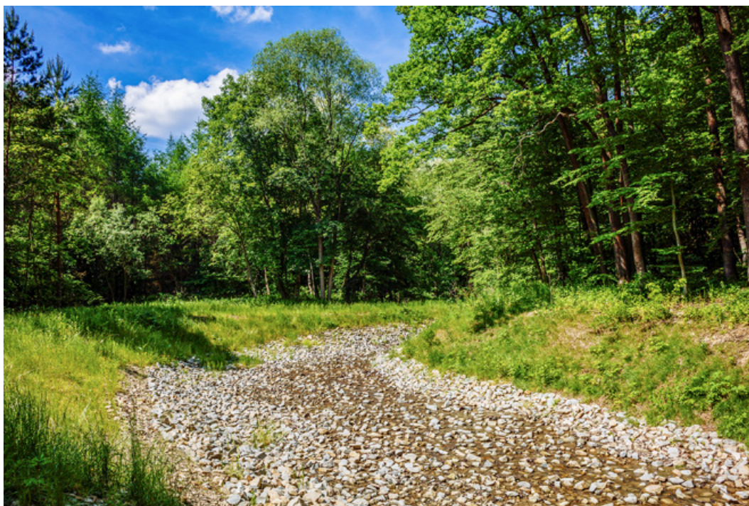
Fot. 90. Bystrze o zwiększonej szorstkości w miejscu rozebranego betonowego jazu w Nadleśnictwie Krasiczyn, przywracające ciągłość biologiczną cieku (archiwum CKPŚ)
