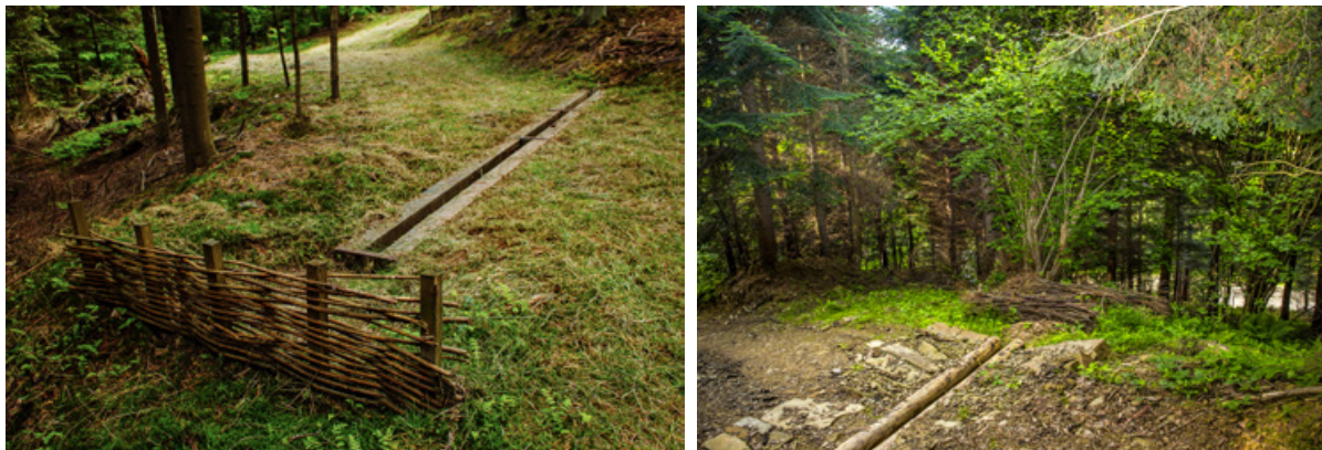
Fot. 134. i Fot. 135. Płotki faszynowe przeciwoerozyjne rozpraszające wodę na stok, Nadleśnictwo Gromnik (archiwum CKPŚ), Nadleśnictwo Łosie (archiwum CKPŚ)
