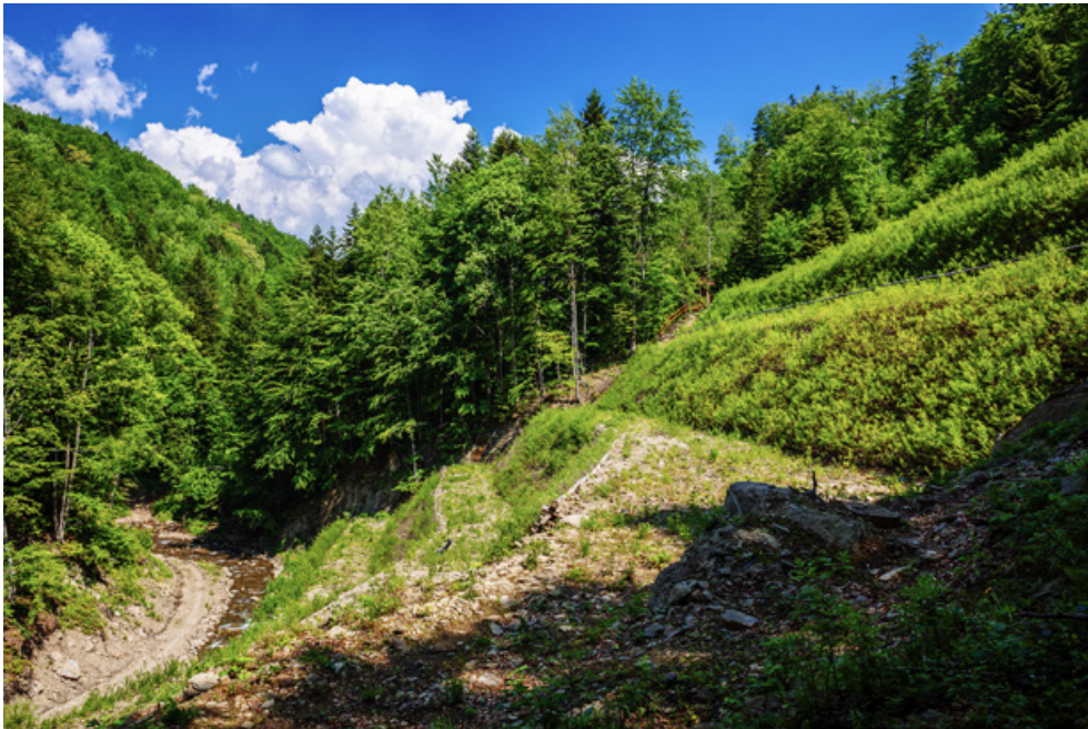
Fot. 80. Kaszyca z pędami wierzby zabezpieczająca osuwisko pod drogą podcinaną przez ciek, Nadleśnictwo Stuposiany (archiwum CKPŚ)
