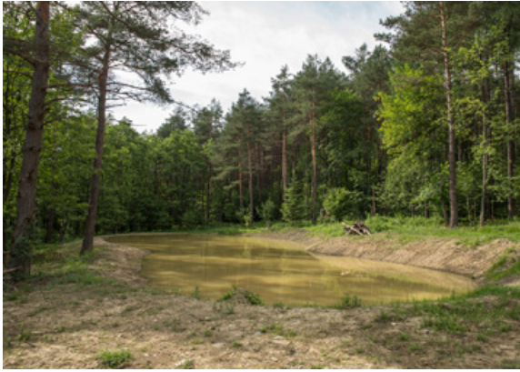
Fot. 116. Zbiornik retencyjny na spływ powierzchniowy zaraz po wybudowaniu, Nadleśnictwo Łosie (archiwum CKPŚ)
