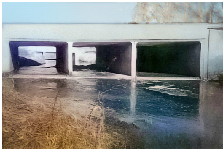
Fot. 124. Błędnie zaprojektowana rzędna dna ograniczająca migrację ryb podczas niżówek [Kosicki 2011]
