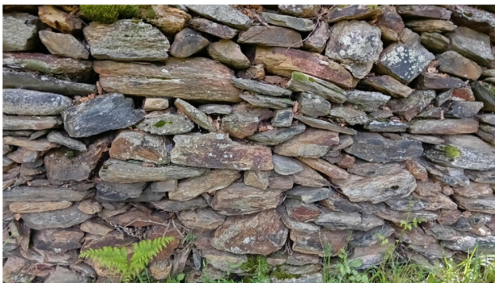
Fot. 72. Murek kamienny bez zaprawy, Targaniczanka (fot. L. Książek, 2025)
