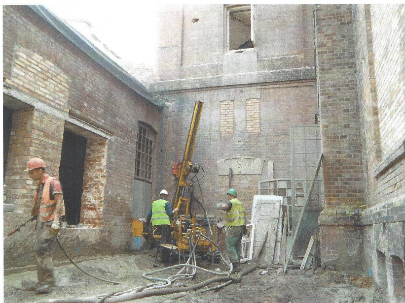
Fot. 2. Wykonywanie kolumn „jet grouting” przy wieży
