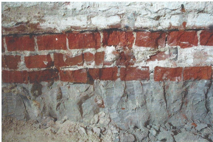
Fot. 3. Odsłonięte kolumny „jet grouting” wzmacniające posadowienie budynku
