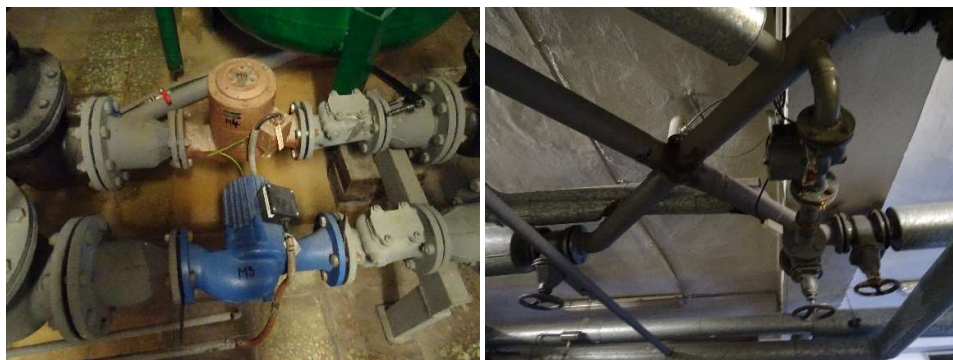
Obr. 4: Obehové čerpadlá, štvorcestný zmiešavací ventil
