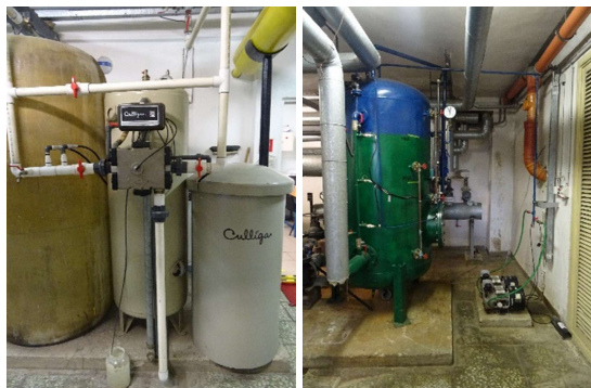
Obr. 5: Chemická úpravňa vody, expanzná nádoba
