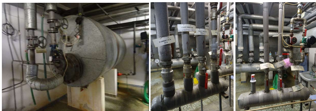
Obr. 7: Ležatý zásobníkový ohrievač TV, rozdeľovač a cirkulácia TV
