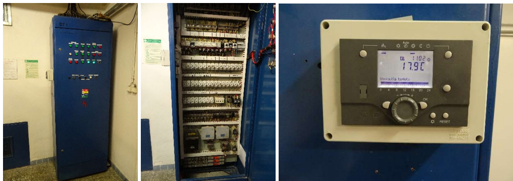
Obr. 6: Riadiaci systém kotolne a ekvtermická regulácia
