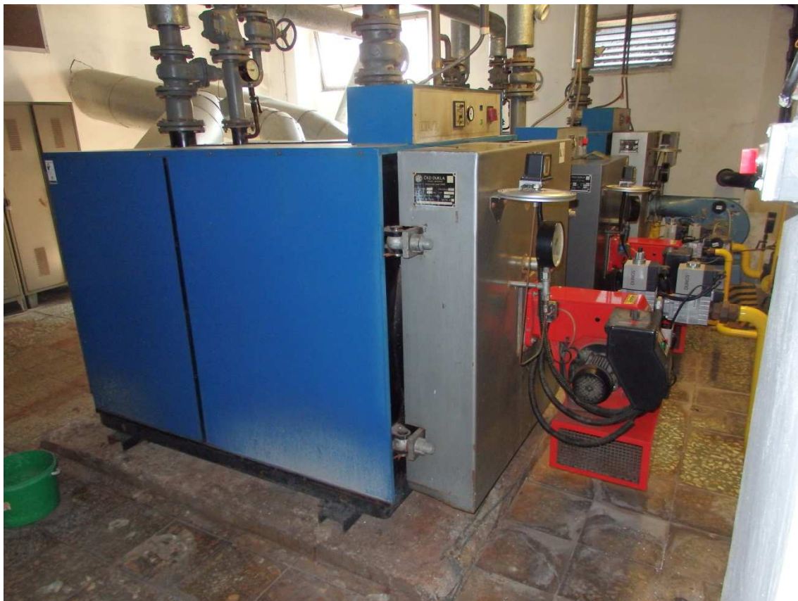
Obrázok 14: Kotel ČKD Dukla – 650 kW
