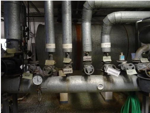
Obr. 3: Rozdeľovač vykurovacej sústavy
