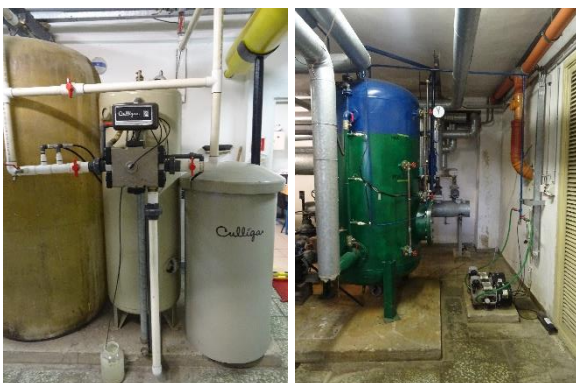
Obr. 5: Chemická úpravňa vody, expanzná nádoba
