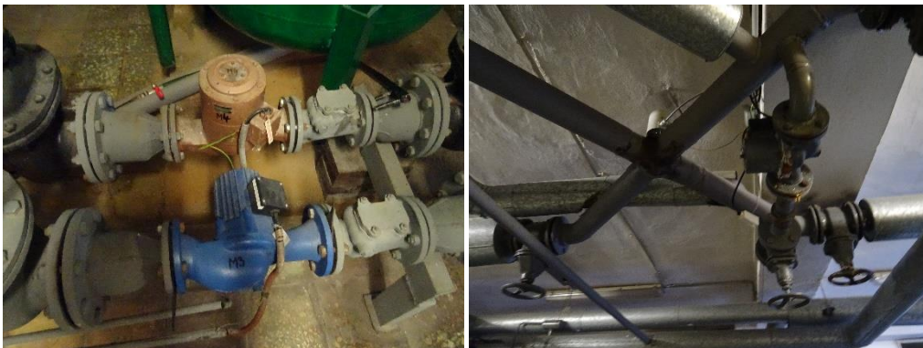
Obr. 4: Obehové čerpadlá, štvorcestný zmiešavací ventil
