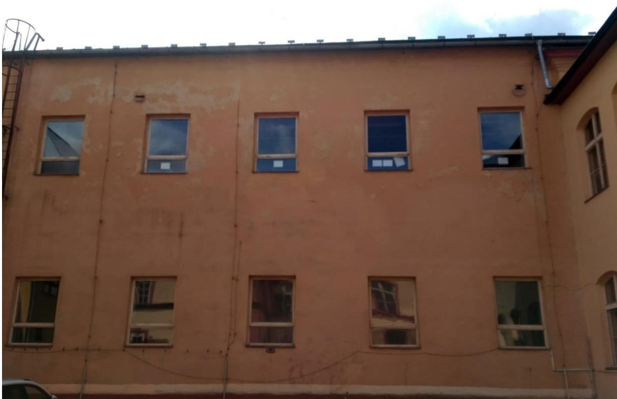
10ks okno 3-krídlové 150x210, plast (chodba+telocvična, pôvodné okná sú 2-krídlové)
